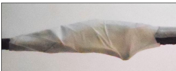
f) Proteção com fita crepe
