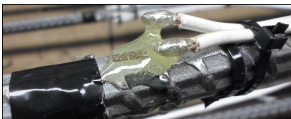
d) Proteção com adesivo epóxi
