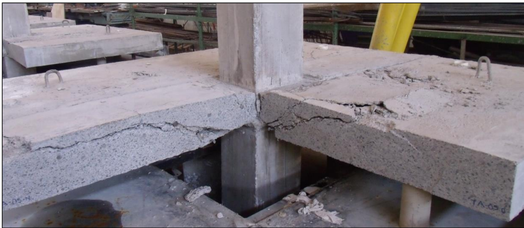
a) Vista do quadrante Noroeste da laje TA-05
