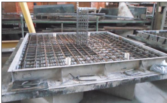
c) Posicionamento das armaduras
