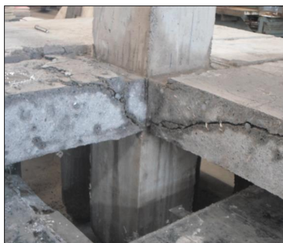
b) Quadrante retirado da laje
