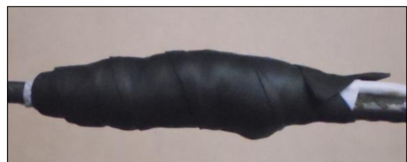
g) Proteção com fita isolante
