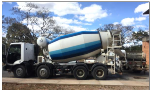
d) Recebimento do concreto
