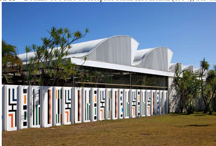
Figura 25 – Detalhe do Muro do Hospital Sarah Kubtischek (1994), Salvador/Ba.
