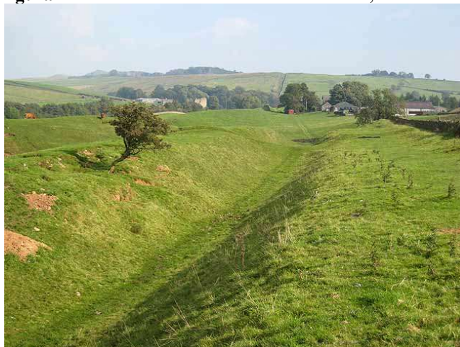
Figura 2 – Vala e Muro de Ariano – Nortúmbria, Grãbretanha
