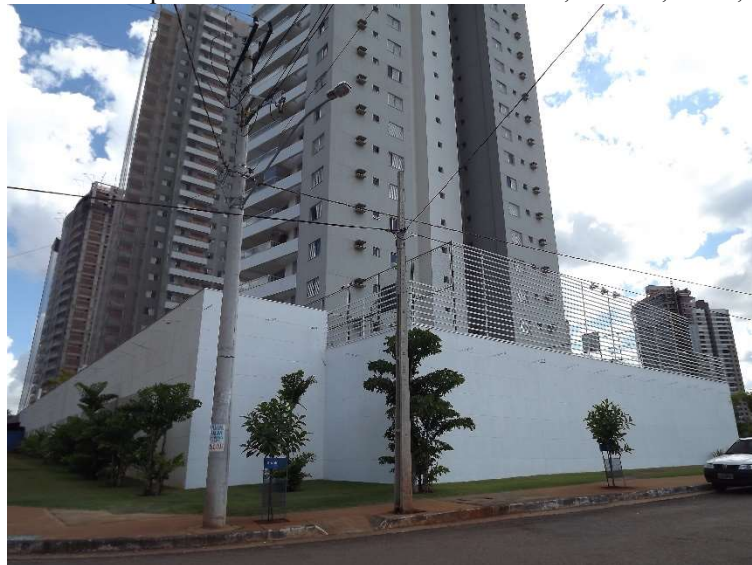
Figura 12 – Muro/parede limítrofe de edifício residencial, Goiânia, Goiás, Brasil.
