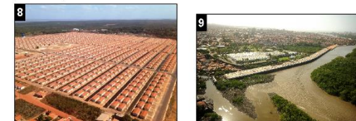
Conjunto habitacional no município de São José de Ribamar, (à esquerda). Construção da Av. Quarto Centenário e de moradias na margem esquerda do rio Anil (à direita).
