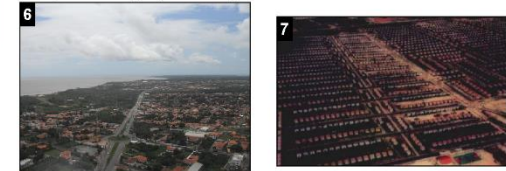
Expansão urbana à nordeste da Ilha (à esquerda) e conjunto habitacional Cidade Operária construído na década de 1980 (à direita).
