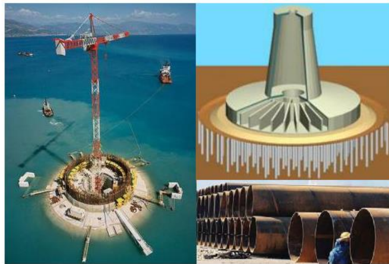
Figura 2.8. Inclusões de aço da ponte sobre o rio Antirion (Pecker, 2004)
