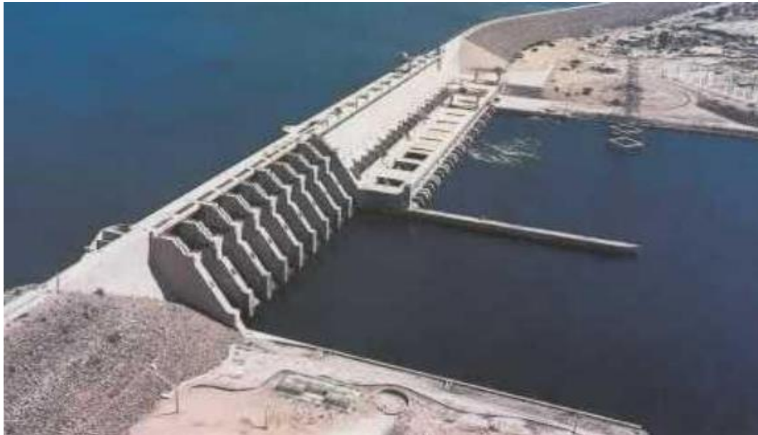
Figura 6. Usina hidrelétrica Luiz Gonzaga (Itaparica) Fonte. CHESF (2000).
