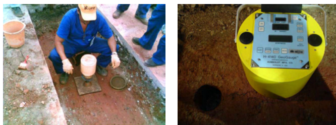
Figura 5.4 - Trincheira de inspeção e realização de ensaios de campo. Aparelho Geogauge em uso no AIB (Farias & Falcão, 2006)
