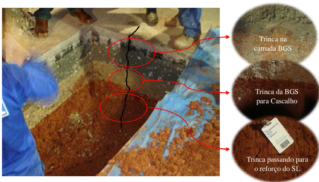
Figura 2.20 - Trincheira para inspeção na nova pista do AIB (Farias & Falcão, 2006).
