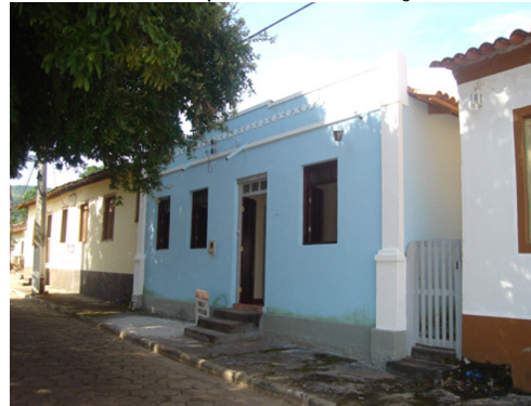
Depois da Intervenção
