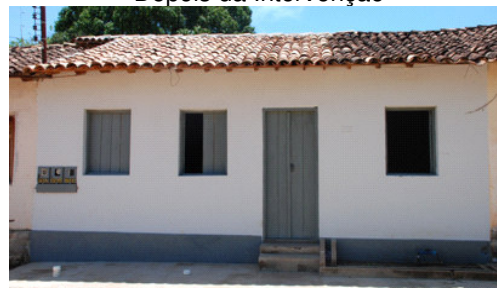
Depois da Intervenção
