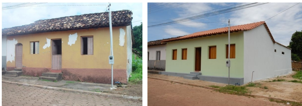
Figura 18 – Edificação antes da intervenção e a Figura 19 – Edificação depois da intervenção
