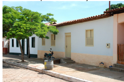
Depois da Intervenção
