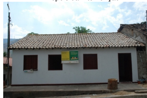
Depois da Intervenção
