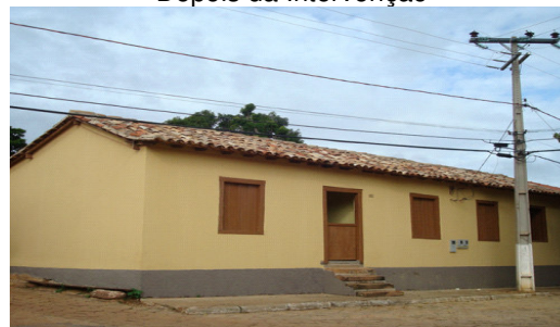
Depois da Intervenção
