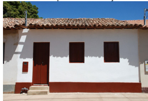
Depois da Intervenção
