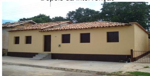
Depois da Intervenção
