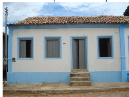
Depois da Intervenção
