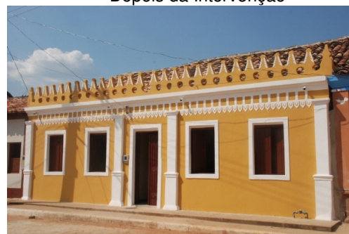
Depois da Intervenção
