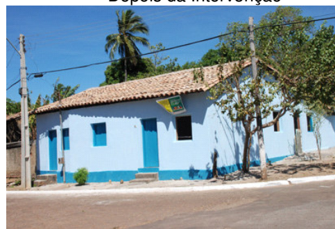
Depois da Intervenção
