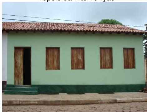
Depois da Intervenção
