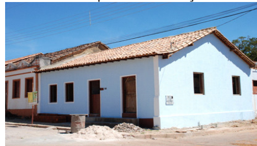
Depois da Intervenção
