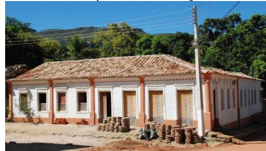
Depois da Intervenção
