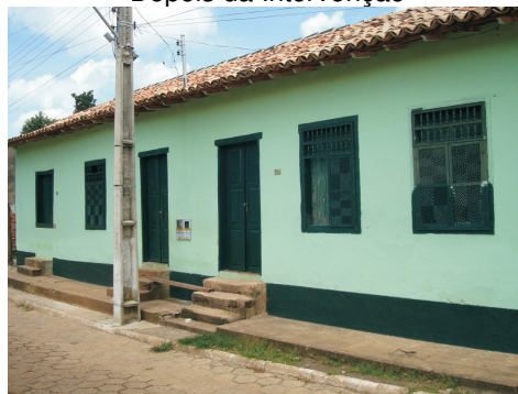
Depois da Intervenção
