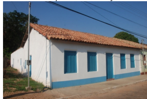
Depois da Intervenção
