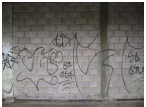
Figura 18 e 19: de breve espaço cultural a parede de concreto
