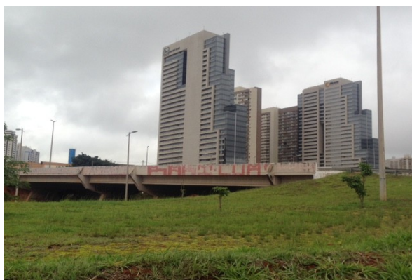
Figura 16: Viaduto na entrada de Taguatinga (via EPTG). Foto de Renata Almendra, 2018
