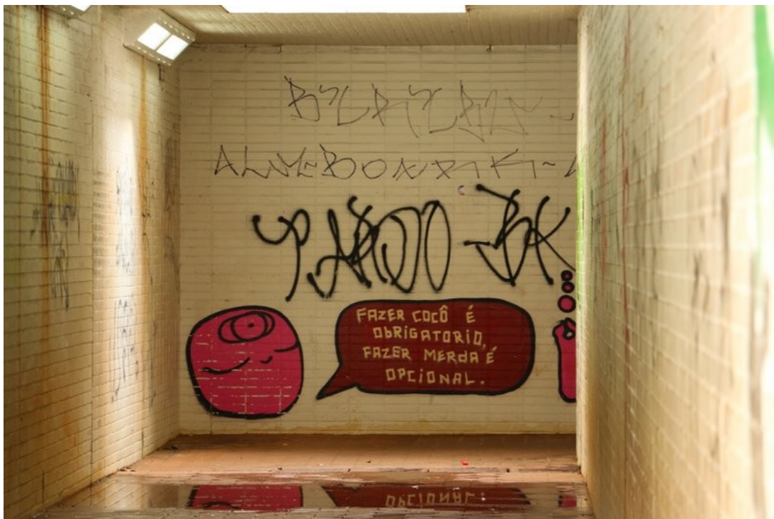
Figura 32: Passagem subterrânea na Asa Sul. Foto de Juliana Torres, 2017
