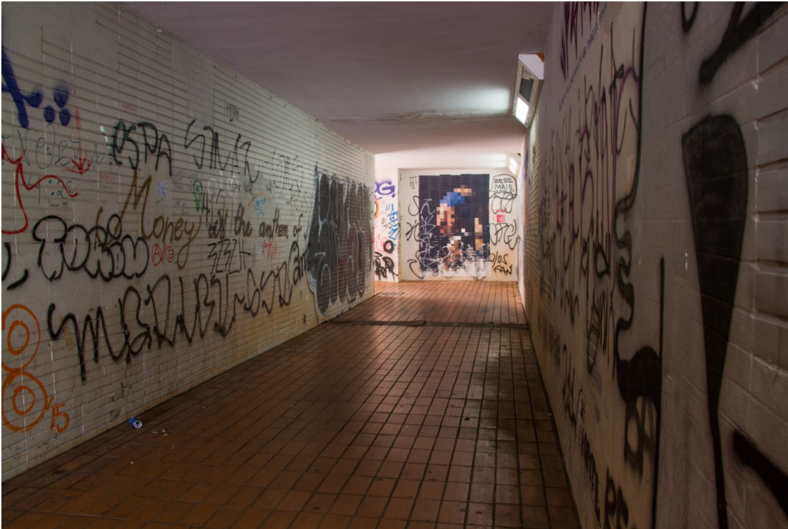
Figura 24: Passagem subterrânea na Asa Norte. Foto de Juliana Torres, 2017
