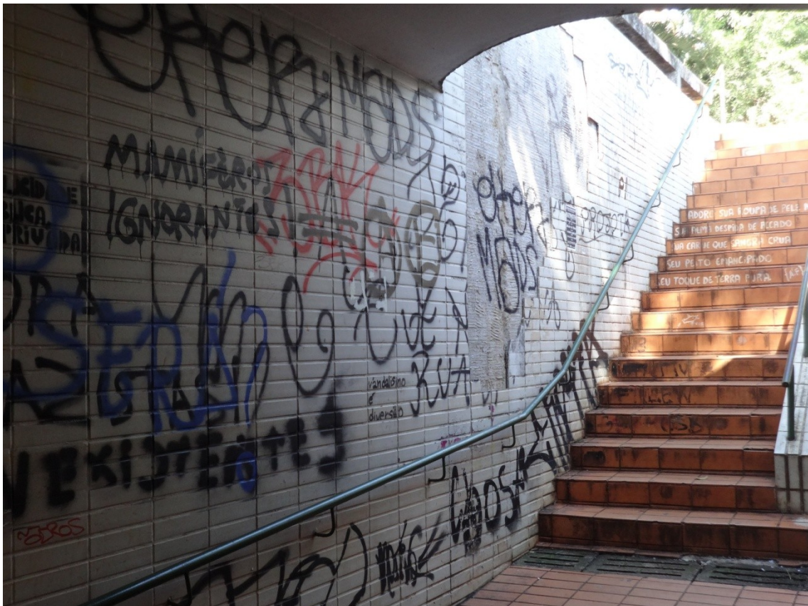
Figura 30: Entrada de passagem subterrânea na Asa Norte. Foto de Renata Almendra, 2018
