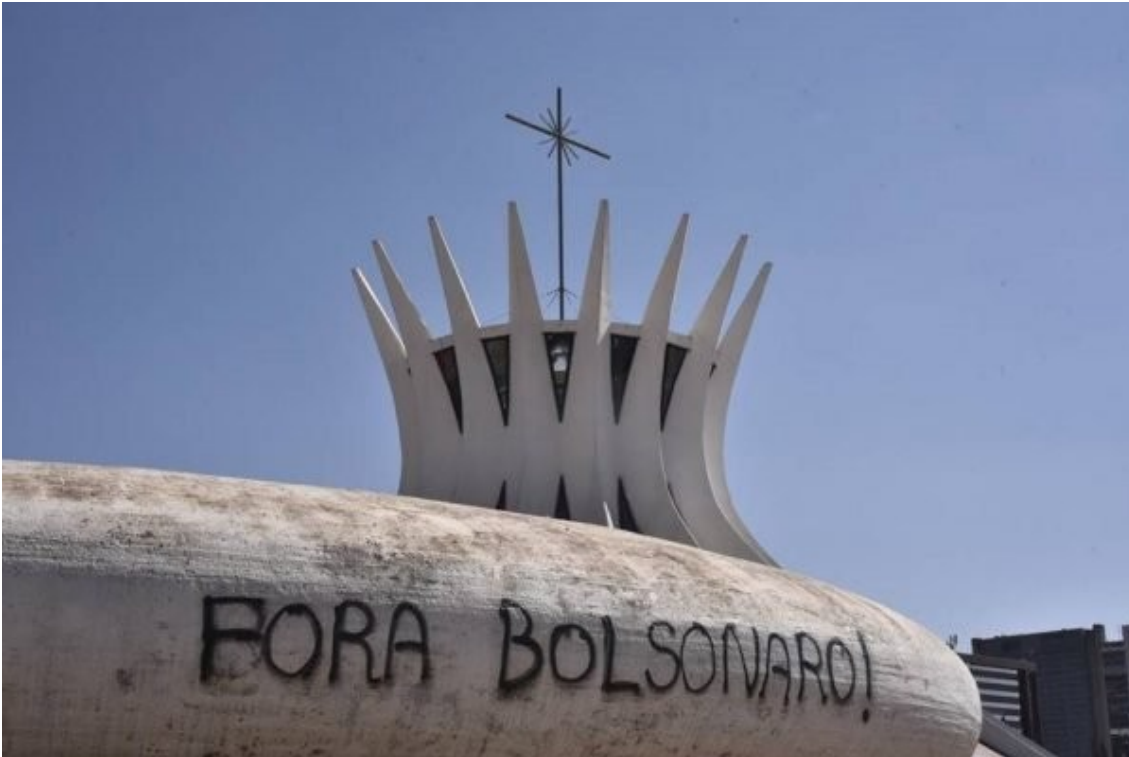
Figura 55: Pichação na parede externa do batistério da Catedral Metropolitana de Brasília. Foto de Hugo Barreto publicada no Jornal Metrôpoles em 10/09/2019. Disponível em: < https://www.metropoles.com/distrito-federal/pichacao-fora-bolsonaro-na-catedral-de-brasilia-viraliza-na-web >, acesso em: 29/09/2020
