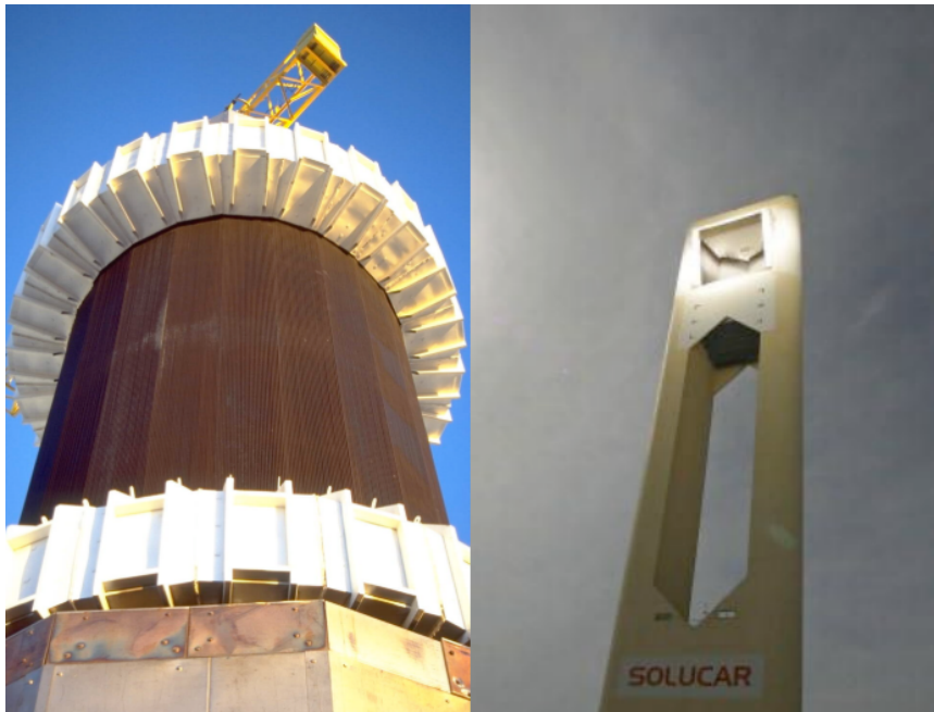
Figura 2.7: Receptor cilíndrico (esquerda) e Receptor de cavidade (direita) (Wagner, 2008).
