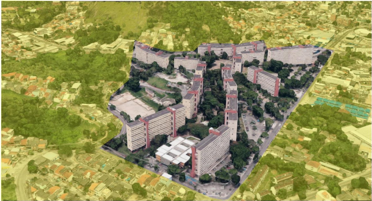
Figura 26 - Conjunto habitacional Cafundá, MBPP Arquitetos Associados, de 1978
