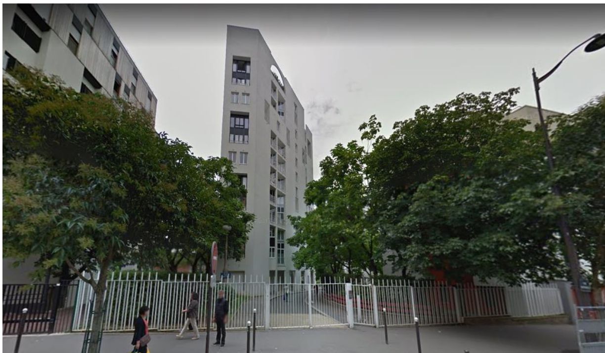
Foto 7 - Vista do Les Hautes Forms a partir da Rue Nationale
