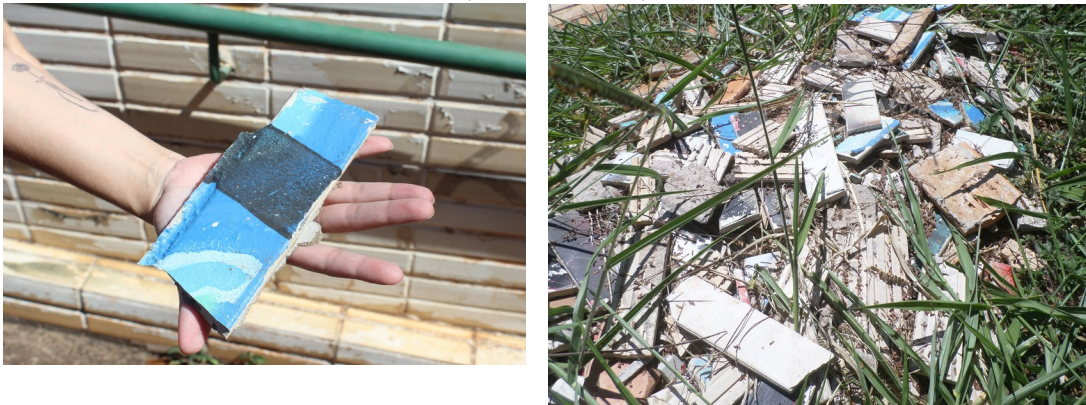
Figure 15: Restos de azulejos grafitados na passagem subterrânea das quadras 103/203 norte, Plano Piloto, Brasília-DF.
