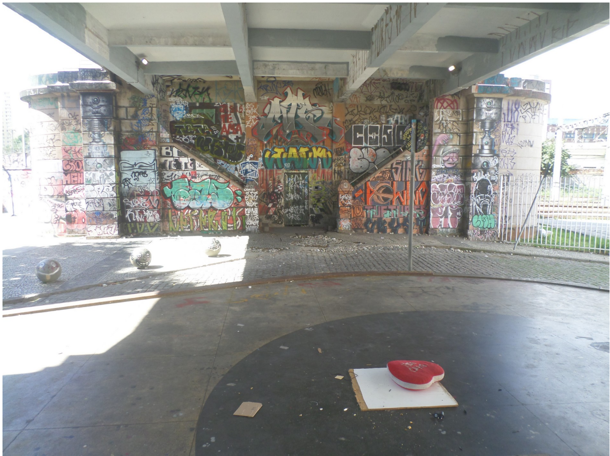
Figura 1 - Viaduto Santa Tereza, Belo Horizonte-MG
