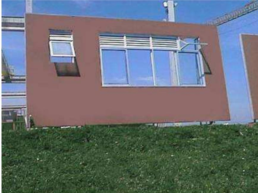
Figura 2.6 – Detalhe do painel pré-fabricado para fachada
