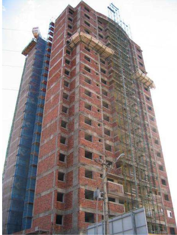
Figura 2.4 – Vedação vertical externa em alvenaria de bloco cerâmico
