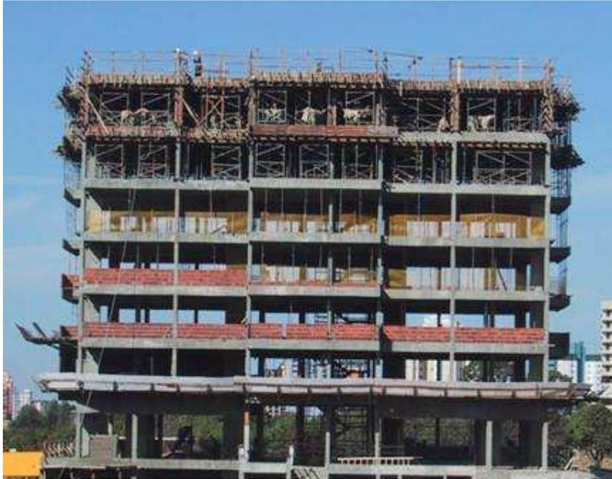
Figura 2.13 – Estrutura convencional com princípio de vedação vertical externa
