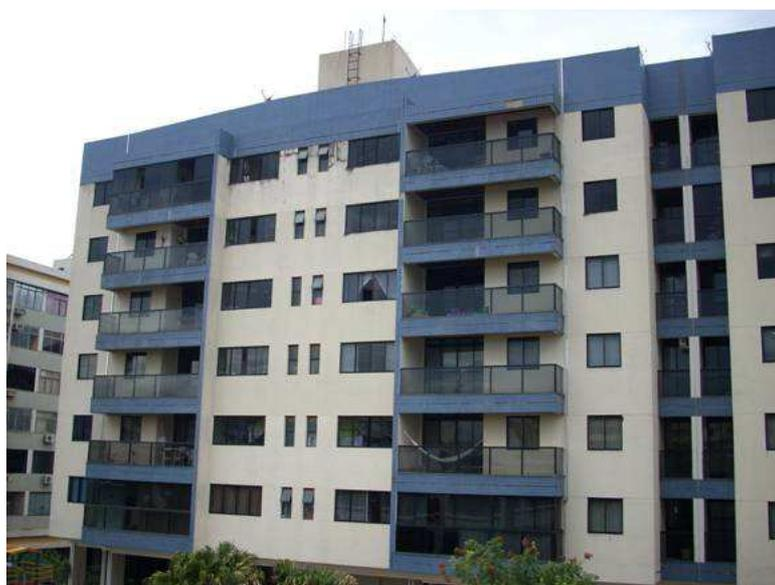
Figura 2.8 – Revestimento de fachada em pintura e pastilhas
