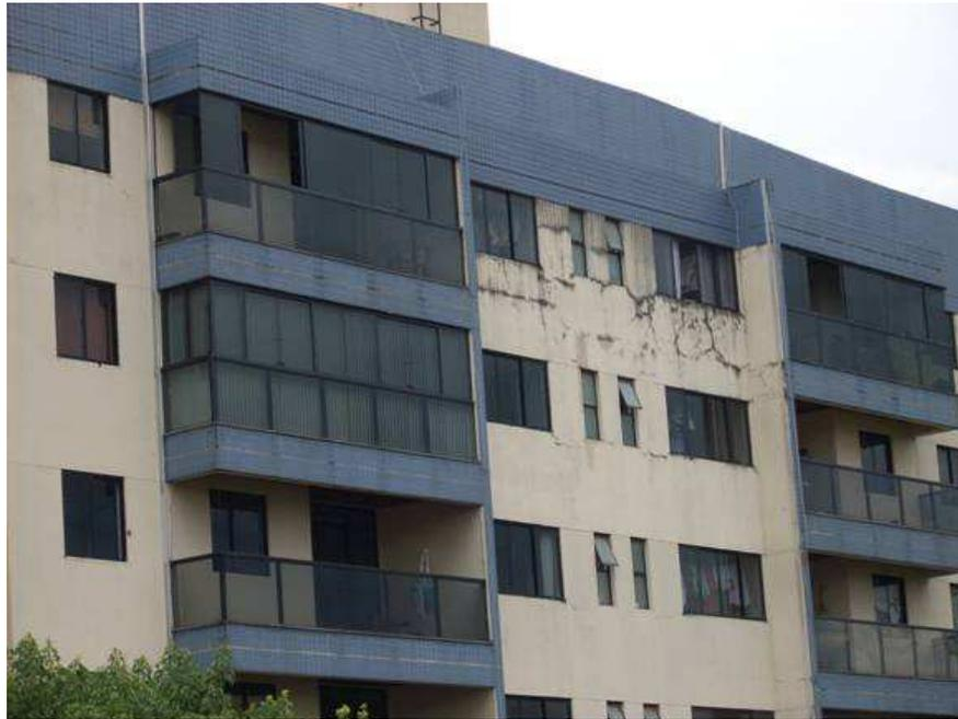
Figura 2.9 – Detalhe de fachada com a pintura apresentando defeitos
