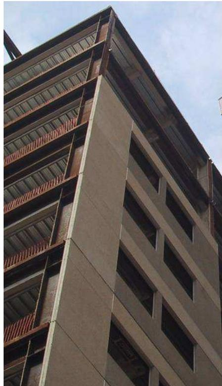
Figura 2.5 – Revestimento de fachada com painéis pré-fabricados
