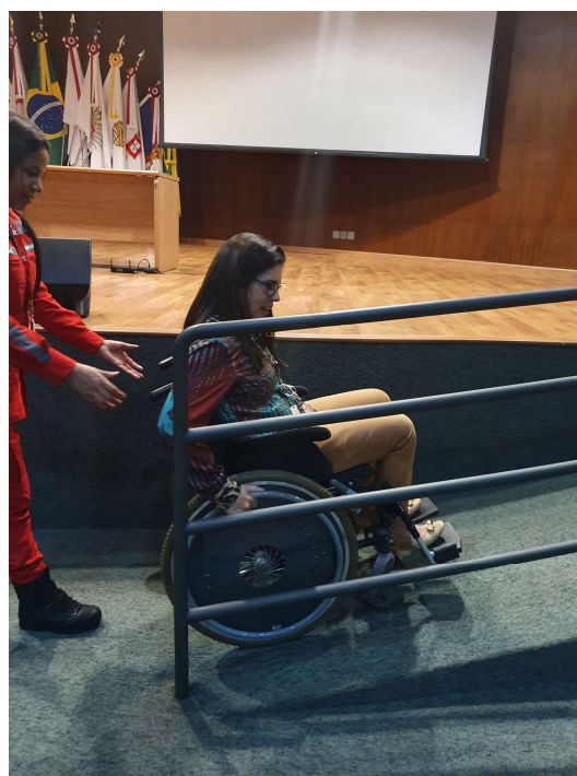
Figura 45 – Rampas do auditório Fonte: Autora
