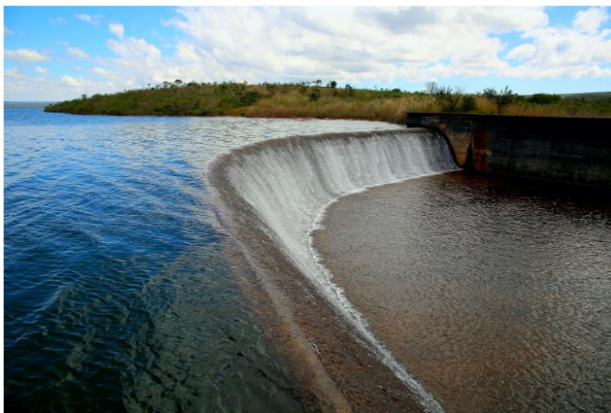
Figura 2: Reservatório de Santa Maria
