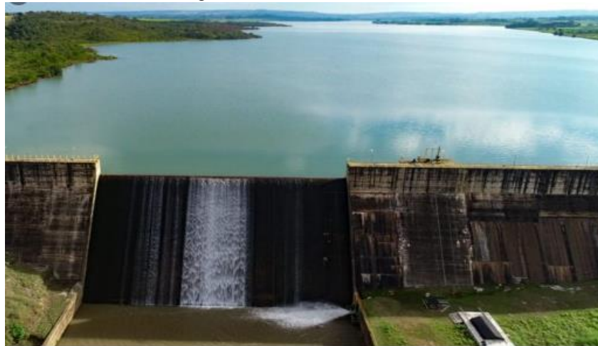
Figura 1: Reservatório do Descoberto
