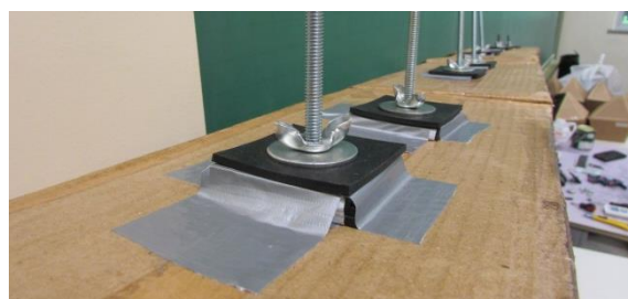
Colocação de dispositivos de fixação
