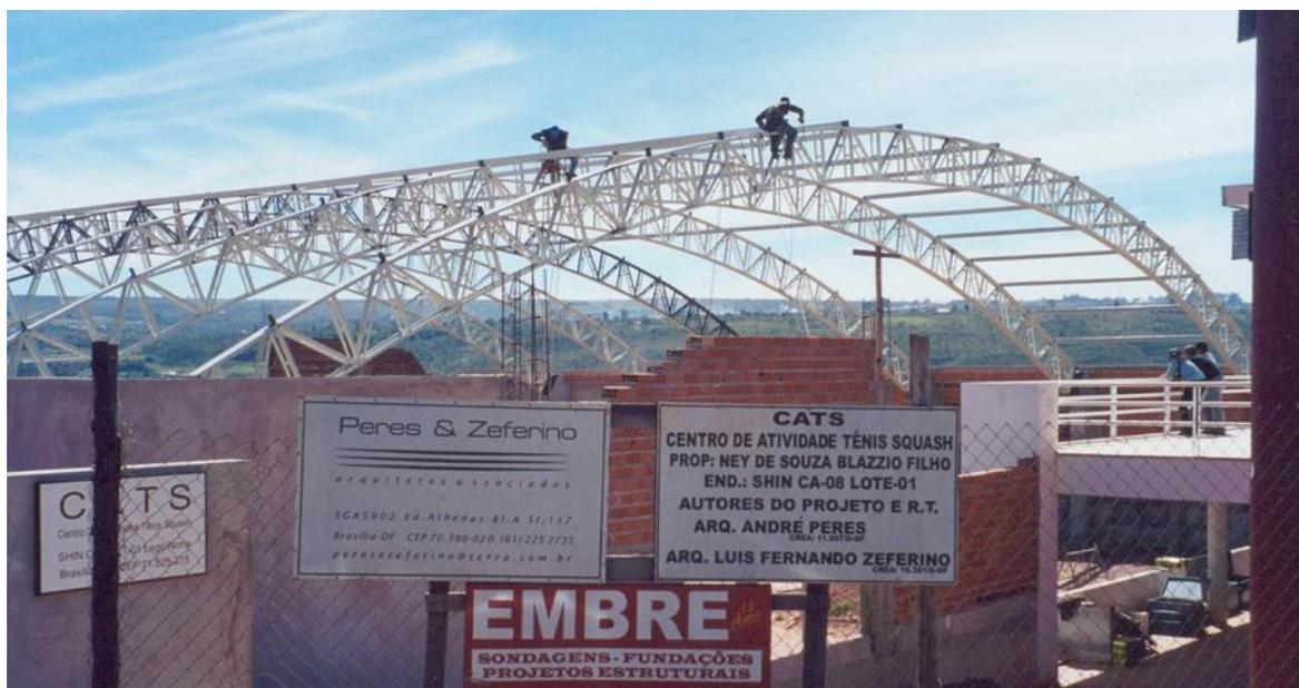
**Figura 5** - Foto da obra durante a montagem da estrutura metálica do ginásio. Foto: LF Zeferino (2002).
