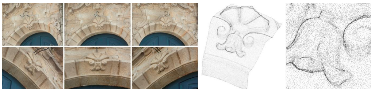
Figura 33 – Processo de fotogrametria para gerar nuvem de pontos 3D, da pedra angular do arco de entrada do Paço Episcopal do Porto, Portugal.
