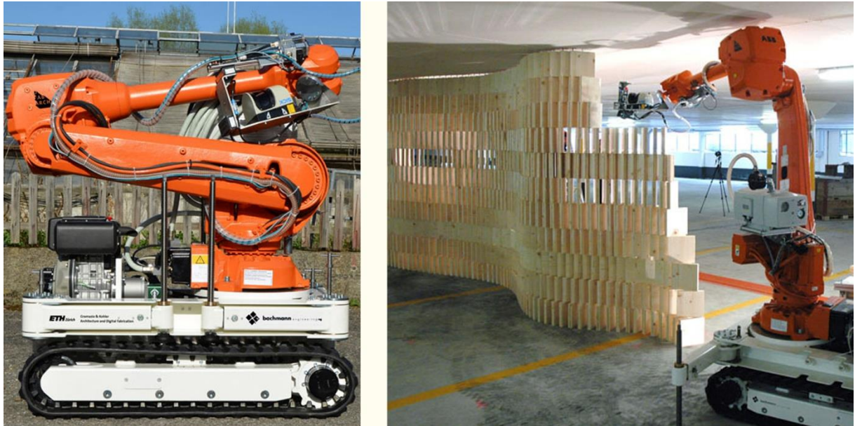
Figura 7 – Experimento de construção robótica em canteiro de obras.
