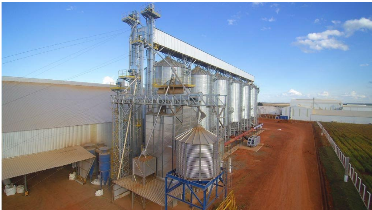
Figura 1A: Vista da Unidade de Beneficiamento de Sementes utilizadas neste trabalho.
