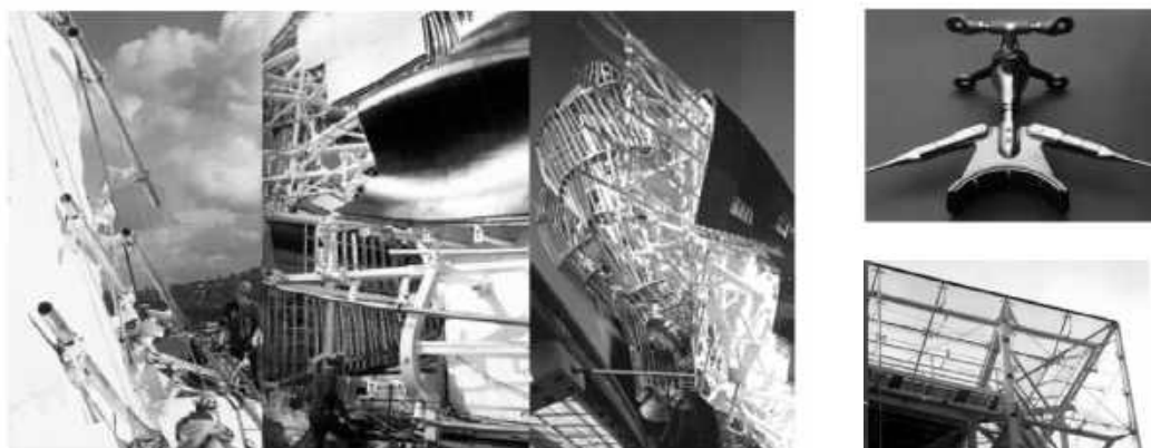
Figura 27 - Sistema de Posicionamento Global (2000) usado na montagem da estrutura. / Figura 28 - Peça desenvolvida por meio da fabricação digital.
