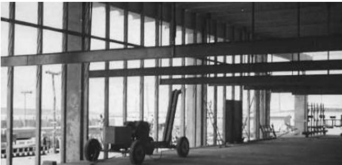
Figura 155 – Vigaento metálico da cobertura e tirantes
