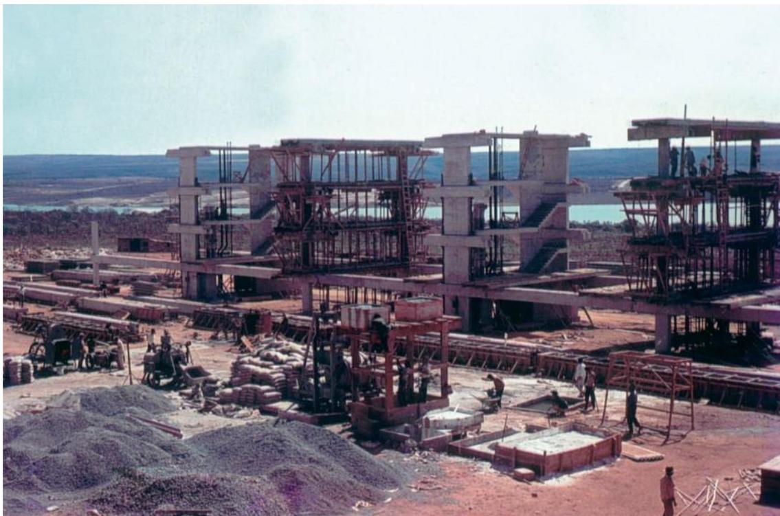
Figura 122 – Construção do Bloco A do conjunto arquitetônico da Colina. Destaque para a produção das vigas no canteiro
