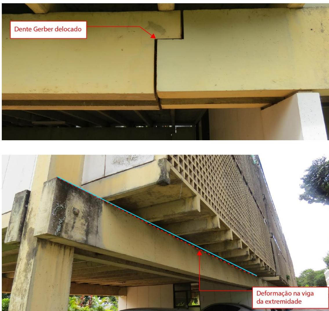
Figura 140 – Inspeção visual. Deslocamento na viga da extremidade
