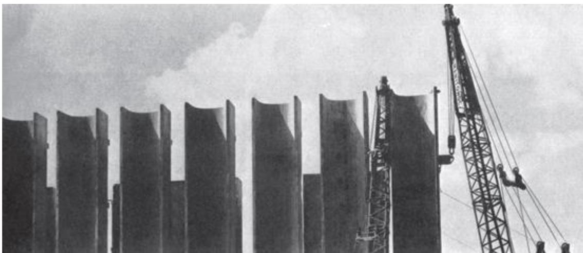
Figura 78 – Sistema de Colunas-paredes pré-fabricadas
