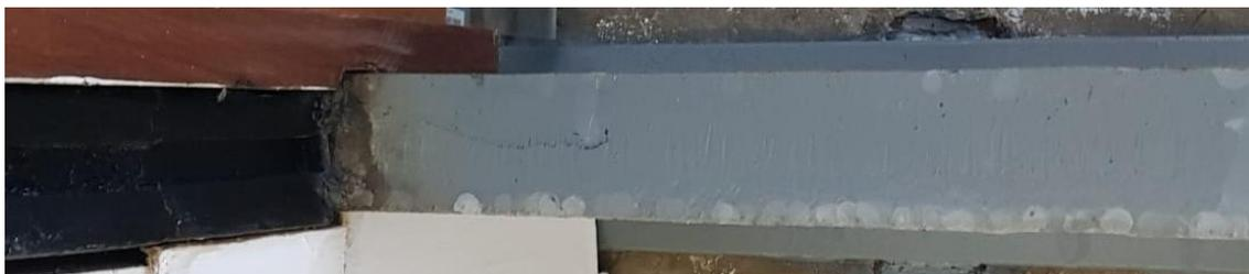
Figura 148 – Perfil com a aba inferior serrada
