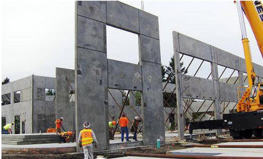
Figura 29. Paredes moldadas no sistema tilti up sendo içadas no local
