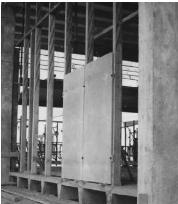
Figura 156 – Fixação dos painéis de vedação
