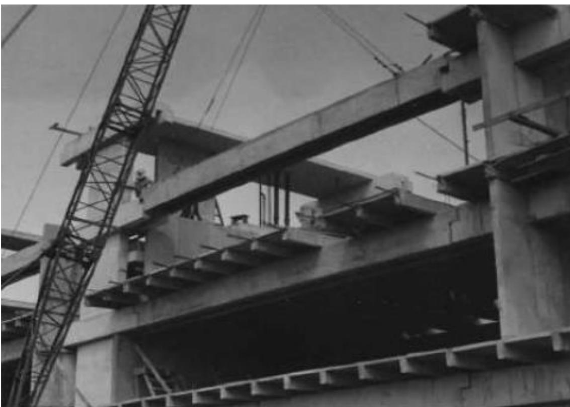
Figura 125 – Início da montagem do terceiro pavimento
