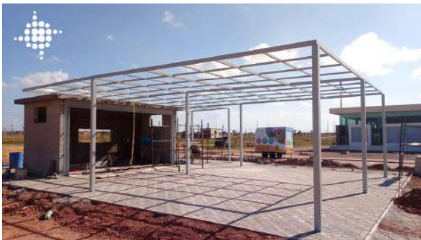
Figura 68 - Obra da cozinha compartilhada. Fonte: http://smartcitylaguna.com.br/galeria/
