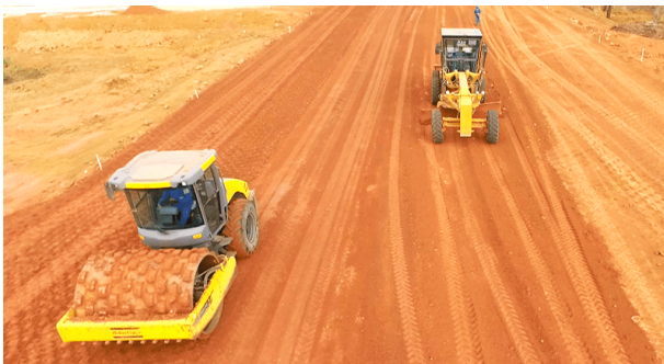
Figura 72 - Terraplanagem. Fonte: http://smartcitylaguna.com.br/galeria/
