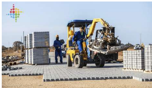
Figura 74 - Assentamento mecanizado do piso intertravado. Fonte: http://smartcitylaguna.com.br/galeria/
