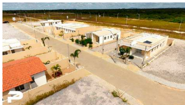
Figura 78 - Bairro da SCL sem rede de energia por cabos aéreos. Fonte: https://smarcitylaguna.com.br/
