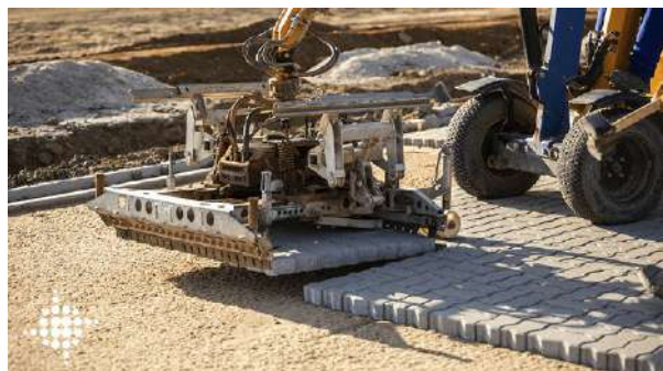
Figura 75 - Assentamento mecanizado do piso intertravado. Fonte: http://smartcitylaguna.com.br/galeria/
