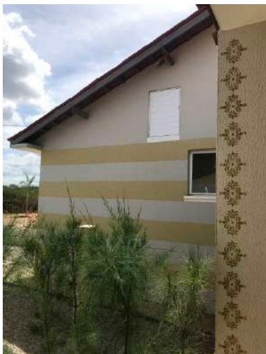
Figura 57 - Sistema de ventilação da casa. Fonte: Autora, 2019.
