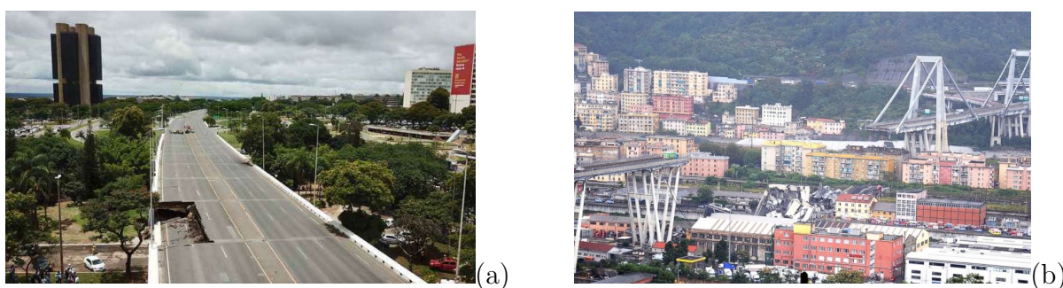
Figura 1.1 – Exemplos de colapsos estruturais em: (a) Viaduto da Galeria dos Estados, Brasília, Brasil (2018); (b) Ponte Morandi, Genova, Itália (2018).
