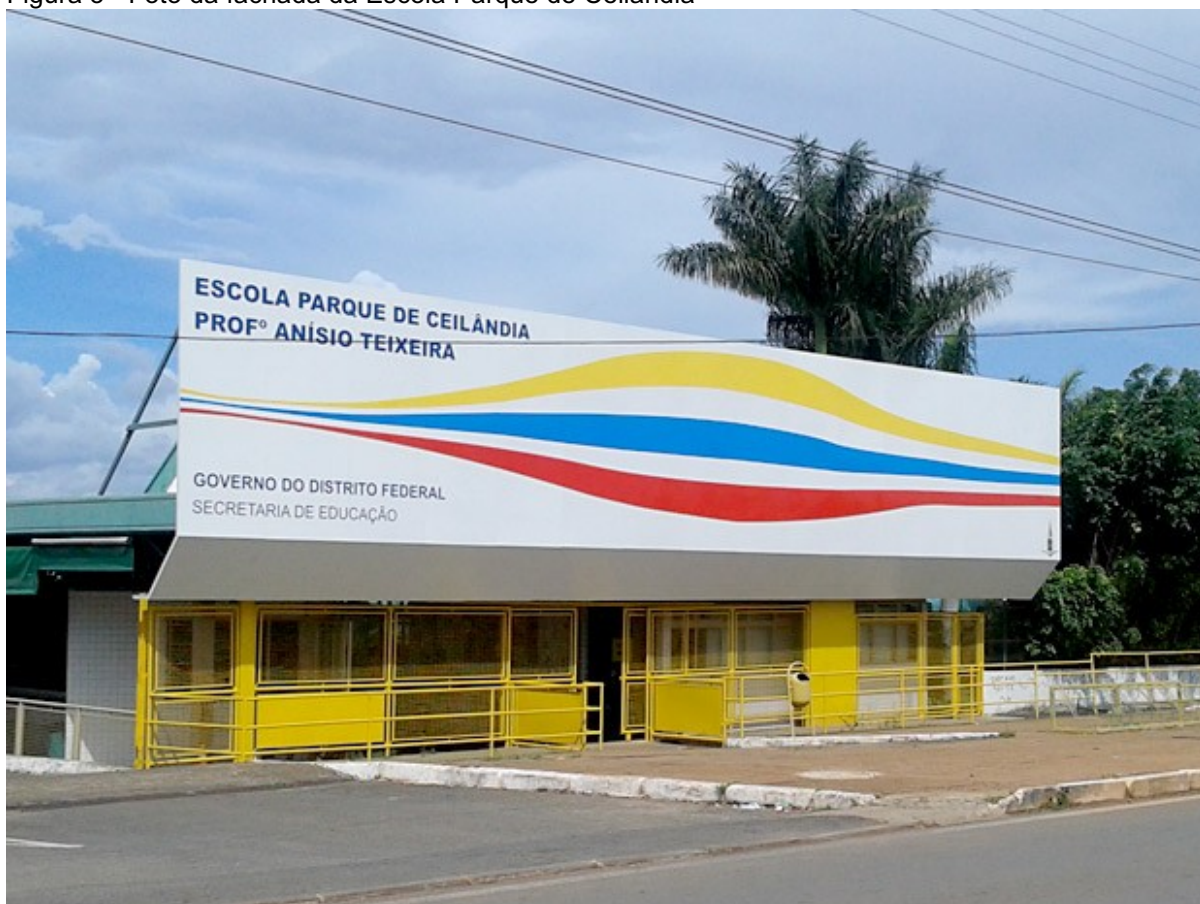
Figura 3 - Foto da fachada da Escola Parque de Ceilândia
