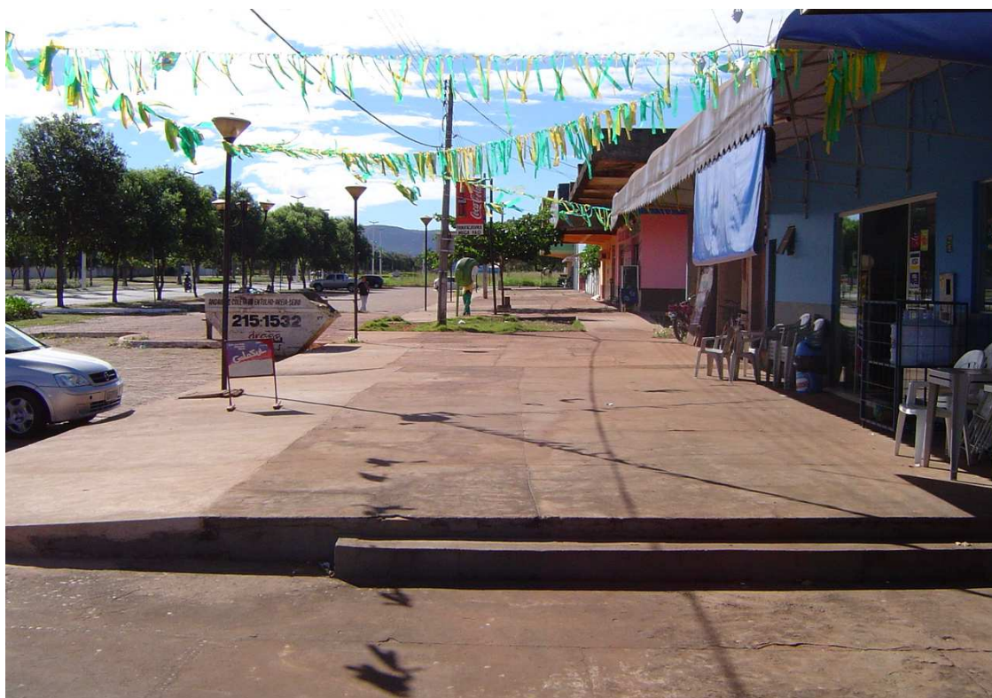
Figura 44: Pavimentação da Av. JK.
