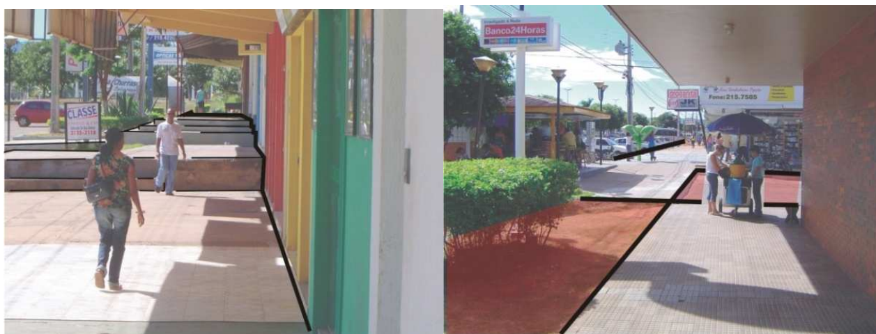
Figura 31: Barreiras arquitetônicas na acessibilidade, Av. JK.
