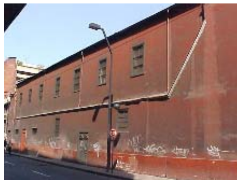
FIGURA 10 – Ausência de relação exterior X interior das edificações FONTE: FUNDACIÓN PAZ CIUDADANA, 2003a, p. 32
