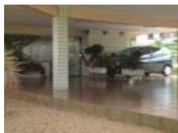
FIGURA 75 - Garagem sob pilotis
