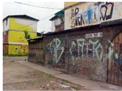
FIGURA 6 – Ausência de conexão visual e manutenção FONTE: FUNDACIÓN PAZ CIUDADANA, 2003a, p. 22
