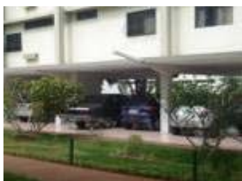
FIGURA 74 - Garagem sob pilotis
