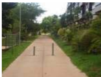
FIGURA 89 – Acesso Leste com pavimentos regulares, sem desníveis, porém há ausência de sombreamento.
