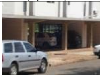
FIGURA 72 - Garagem sob pilotis
