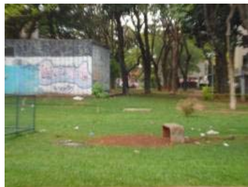
FIGURA 102 – Ausência de manutenção e limpeza
