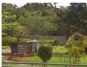
FIGURA 86 – Acesso Oeste sem pavimento em áreas sombreadas. Fechamento da área a partir do cercamento do canteiro de obras.
