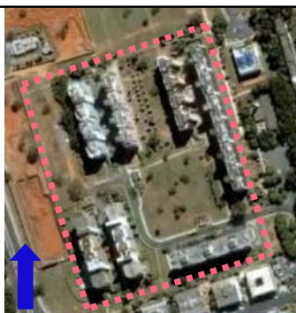
FIGURA 87 – SQN 208, acessos norte, sul, leste e oeste.
