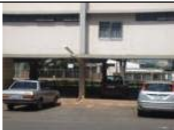
FIGURA 71 - Garagem sob pilotis
