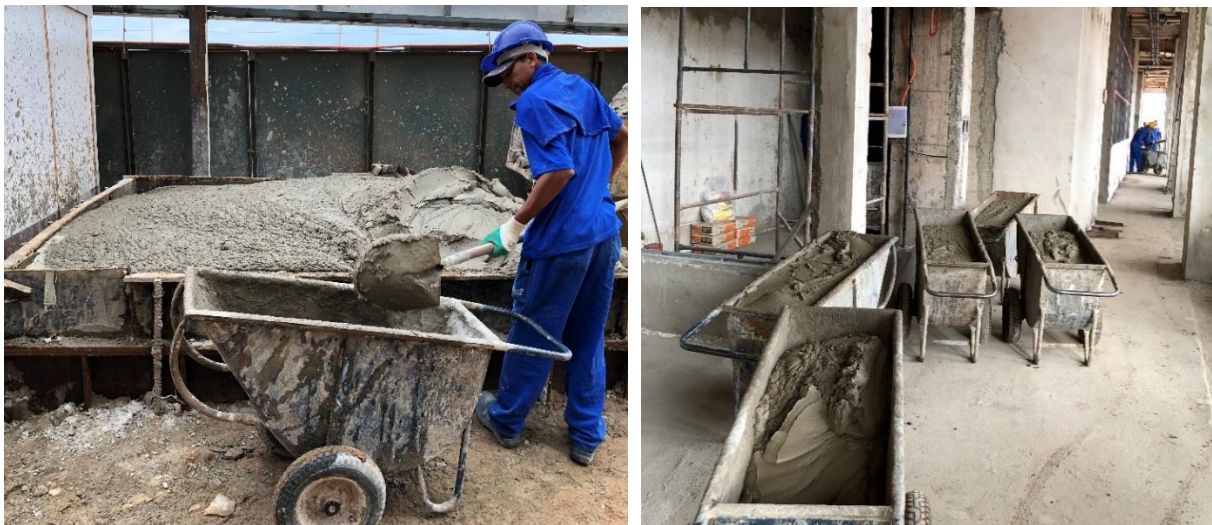
Figura 26 – a) Transporte horizontal da argamassa estabilizada; b) Espera das giricas para subir ao pavimento determinado
