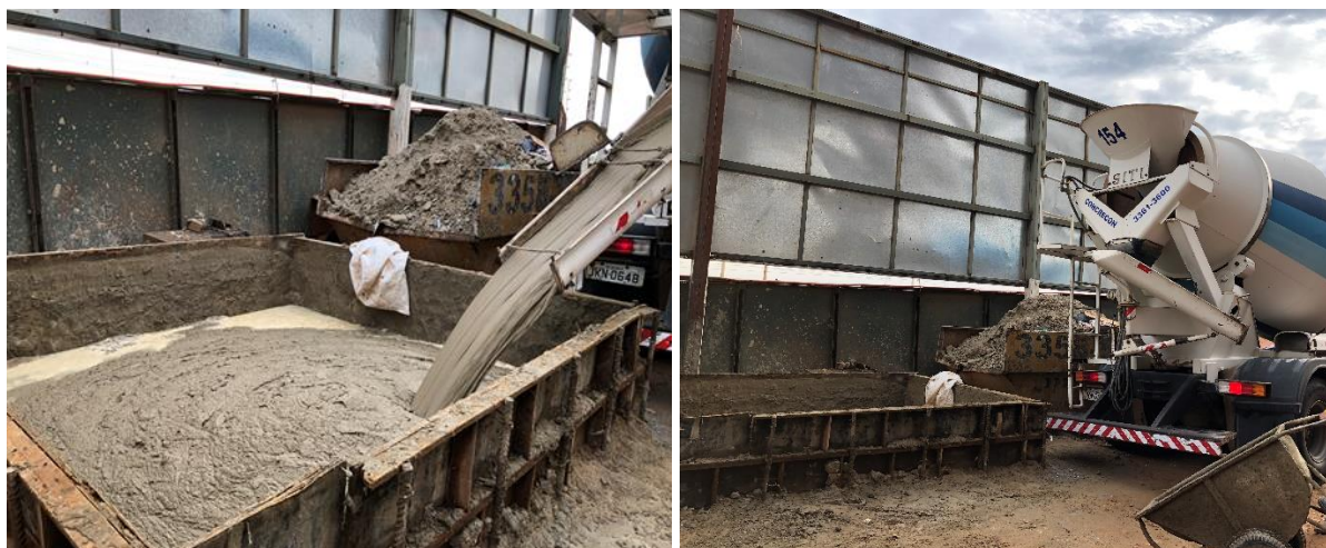
Figura 23 – Chegada do caminhão betoneira para descarregamento da AER no canteiro
