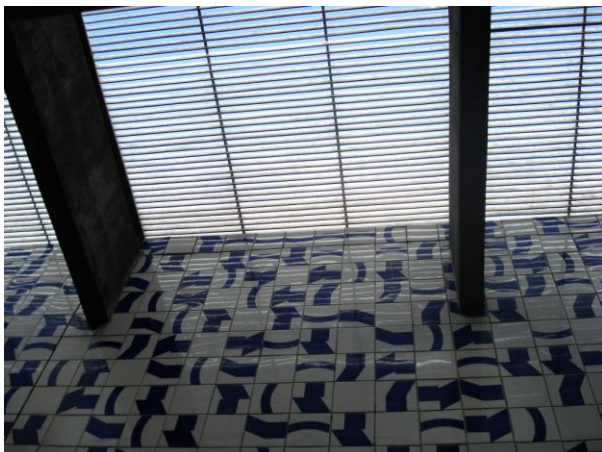
Fig. 6. Detalhe da grade de ferro no teto do Salão Verde, que deixa passar a luz natural
