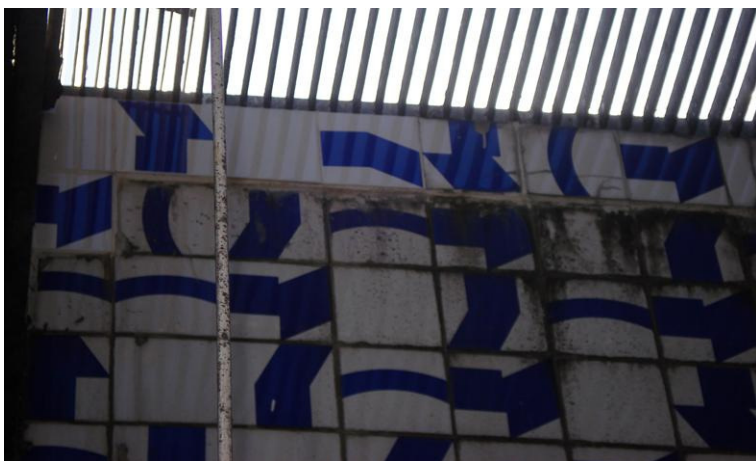
Fig. 21. Detalhe do painel que mostra peças com limo (embaixo) e peças limpas (em cima)
