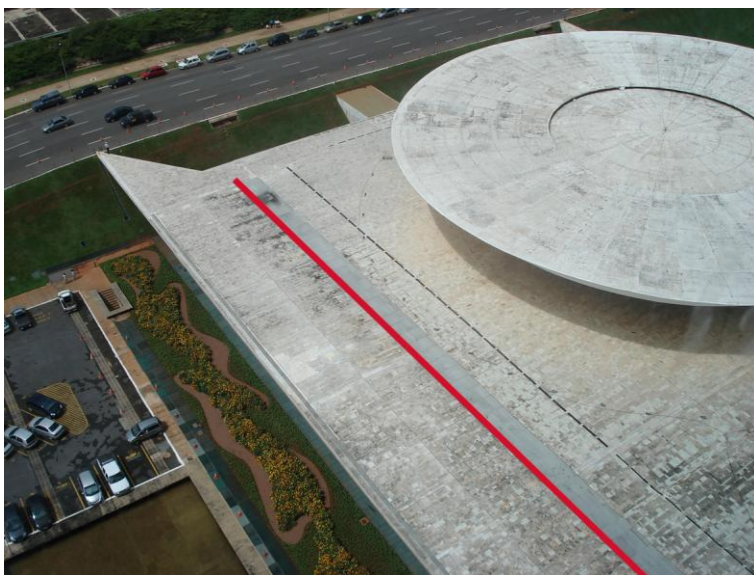
Fig. 15. Vista superior do Palácio do Planalto. A linha destacada mostra os limites originais do edifício
