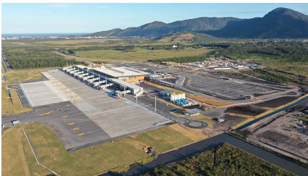
Figura 4.14: Novo terminal do aeroporto internacional de Florianópolis
