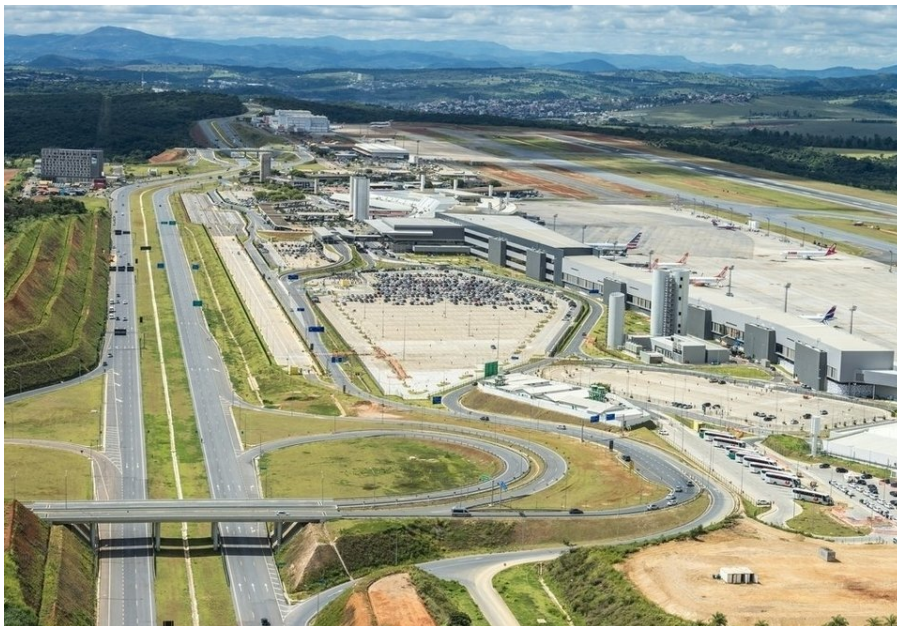
Figura 4.12: Aeroporto internacional de Confins
