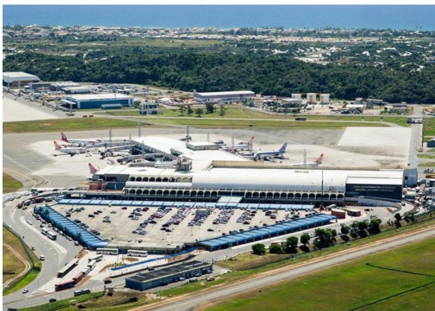
Figura 4.20: Vista área do aeroporto de Salvador
