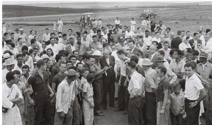
Homens trabalhando na edificação de uma obra. Autor desconhecido (1956-1960).
