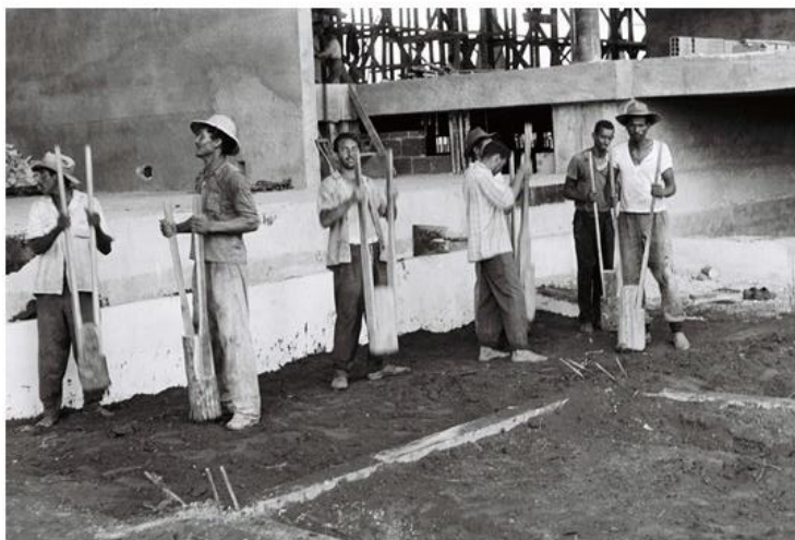
Operários no canteiro de obras do Congresso Nacional. Autor desconhecido (1956-1960).
