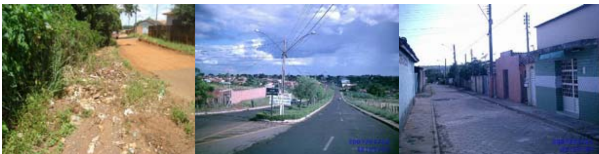
Figs. 96, 97 e 98: Rua de terra do S. Universitário margeando a de mata (à esq.), entrada do C. Branco (meio) e uma das vielas na V. Liberdade que consistem num grave entrave para o trânsito, de difíssima reversão.
