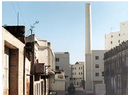
Fig. 80: A cervejaria após a intervenção Fonte: (ARANA, 2001). www.vitruvius.com.br . (Acesso em 11/ 2007)
