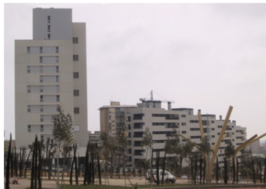
Fig. 76: Habitações de proteção em Kmarx. Barcelona, Espanha. Fonte: http://www.bcn.es (Acesso em 11/2007)
