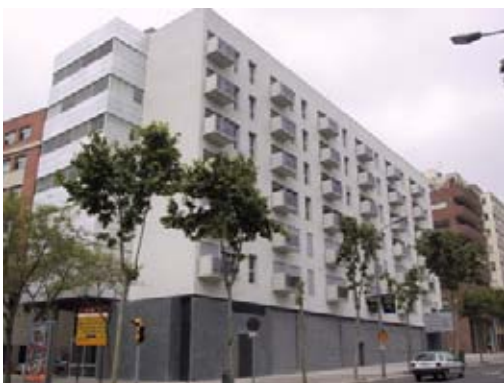
Fig. 77: Moradia de proteção em Montnegre. Barcelona, Espanha. Fonte: http://www.bcn.es (Acesso em 11/2007)
