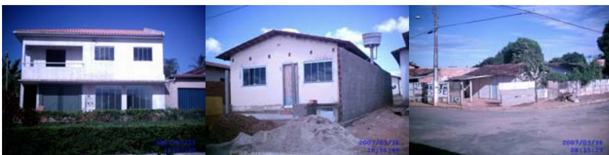
Figs. 124, 125 e 126: Sobrado novo no C. Branco I (à esq.); melhorias nas aberturas e acréscimo de garagem, J. Evelina N. (meio); substituição das telhas de fibro-cimento por telhas cerâmicas francesas, V. Mutirão (à dir.).
