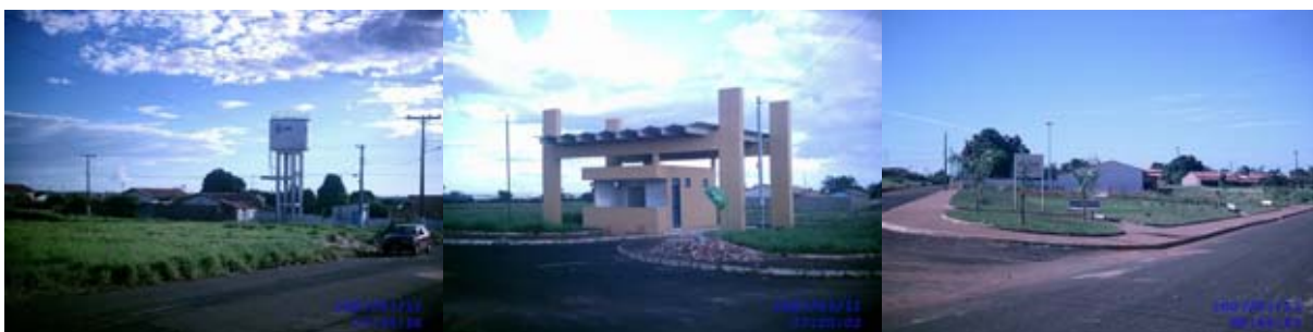
Figs. 148, 149 e 150: grandes quadras livres no C. Branco I, junto ao reservatório de água tratada (à esq.), e do atual centro de inclusão digital (meio); praça do C. Branco II (à dir.).
