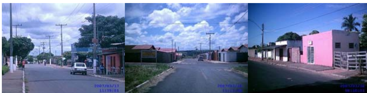
Figs. 93, 94 e 95: Infra-estrutura ok na V. Wilson G. (à esq.) e no J. Evelina N. (meio), e estado de conservação insatisfatório de vias e passeios na V. Mutirão (à dir.).
