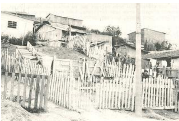
Fig. 6: Jardim Bandeiras (SP). Exemplo de loteamento periférico de casas auto-construídas (Bonduki e Rolnik, 1979:60).
