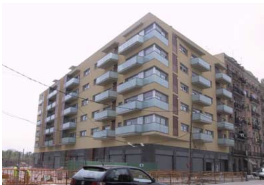
Fig. 75: Habitações de proteção em Fluvia. Barcelona, Espanha. Fonte: http://www.bcn.es (Acesso em 11/2007)
