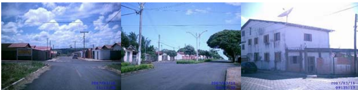
Figs. 99, 100 e 101: rede de energia elétrica em um dos lados da via do J. Evelina N. (esq.), rede de energia e iluminação no canteiro central (meio) de uma av. na V. Liberdade e um poste de madeira na mesma vila (dir.).
