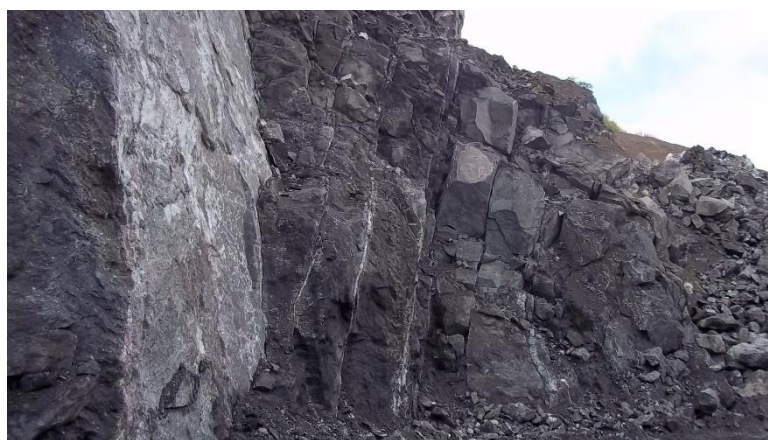
Figura 4.17. Maciço rochoso de jacupiranguito apresentando paredes da descontinuidade lisa, podendo ser plana ou ondulada.
