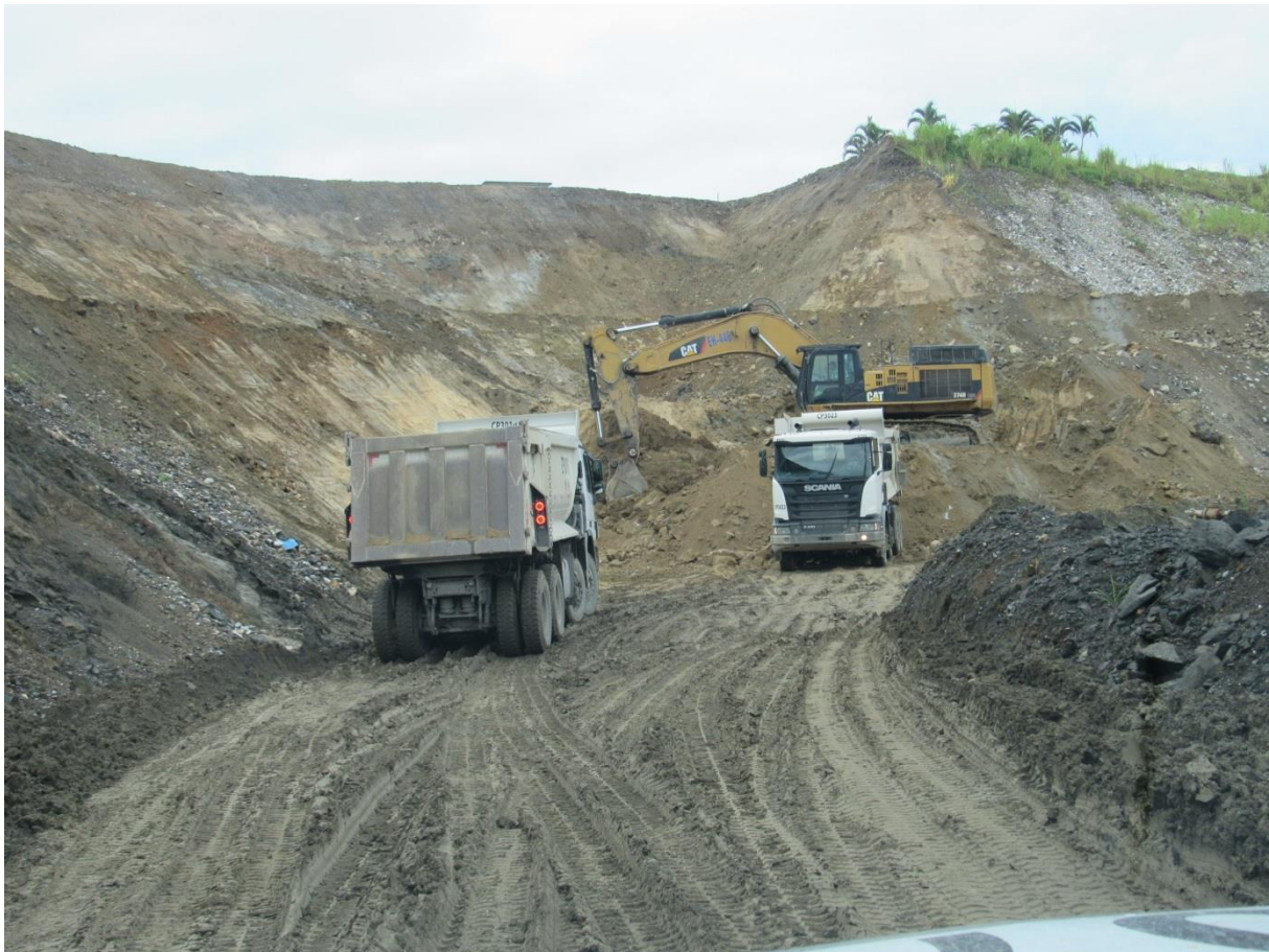
Figura 4.29. Frente de lavra indicando maciço com características de maciço Classe V.
