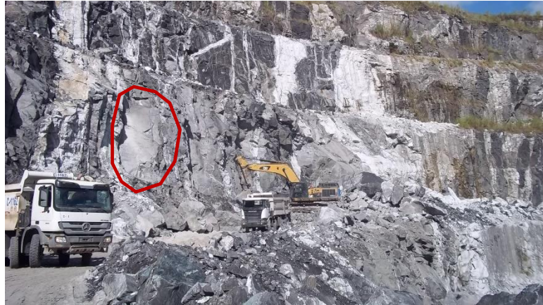
Figura 4.18. Maciço rochoso de jacupiranguito apresentando paredes da descontinuidade polida e plana (destacado em vermelho).
