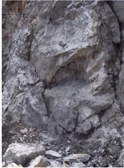
Figura 4.20. Maciço rochoso de Xenólito apresentando paredes da descontinuidade rugosa ondulada.
