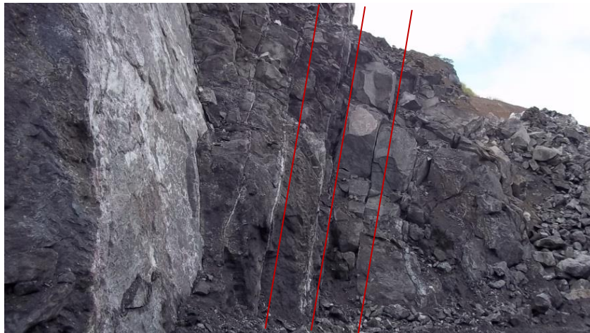
Figura 4.9. Jacupiranguito em talude escavado apresentando plano de faturamento principal, por vezes, preenchidos. Direção do plano principal representando em vermelho, neste caso três planos de fraturamento paralelos.
