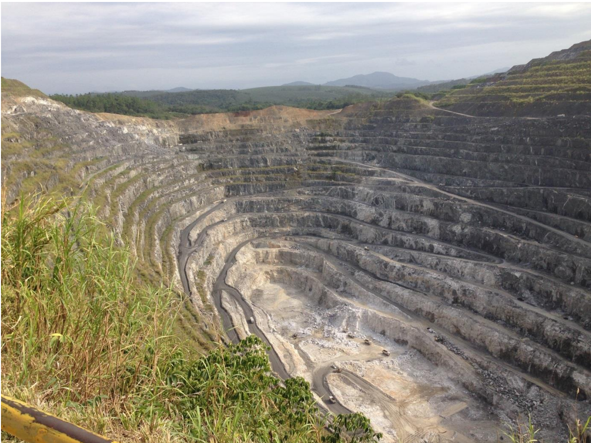
Figura 4.28. Vista semi-panorâmica da cava (atentar para a escala da mina, vide equipamentos no fundo da cava).
