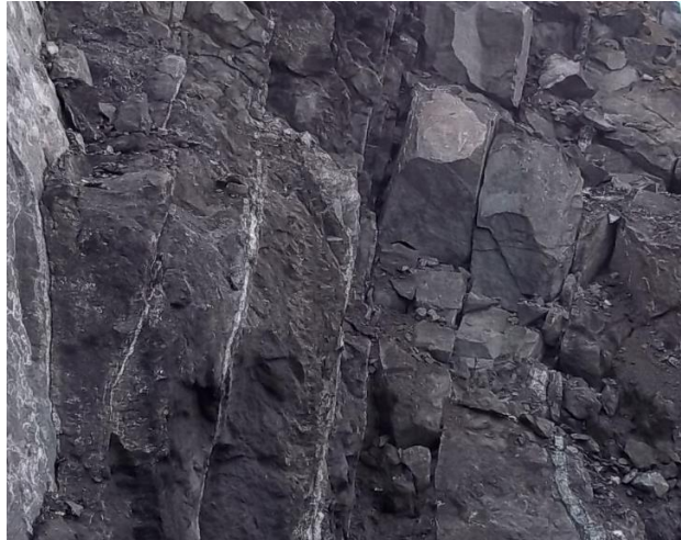
Figura 4.22. Paredes da descontinuidade preenchidas com material silte-argiloso alterado.
