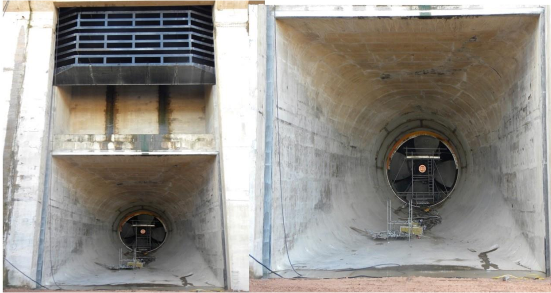
Figura 14. Visão frontal da face do tubo de sucção da unidade geradora (direita) e detalhamento do tubo de sucção (fase construtiva).
