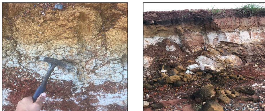
Figura 3.4. Aspecto do perfil no talude da obra de ligação Torto-Colorado. A) Perfil visivelmente alterado/solo saprolítico; B) Fragmentos de metapelitos no perfil de alteração.
