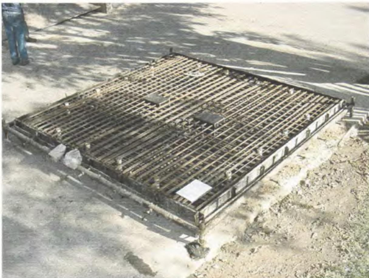
Figura 3.9 – Fotografia da laje com furo e pronta para a moldagem
