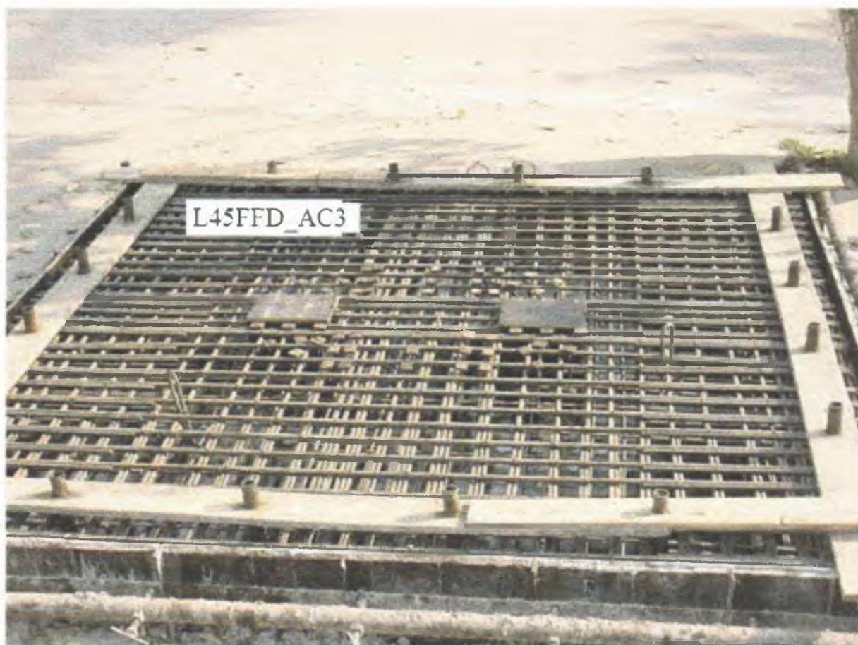
Figura 3.8 – Fotografias da armadura de cisalhamento na armação de flexão das lajes
