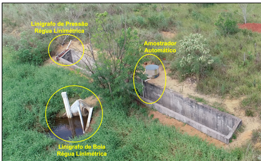
Figura 4.27 – Localização dos equipamentos de monitoramento na saída da lagoa de detenção do Guará.
