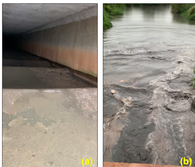
Figura 4.32 – Passagem da onda de cheia na galeria de entrada da lagoa de retenção do Guará: (a) Vista para o interior da câmara 3; (b) Vista de cima da galeria.
