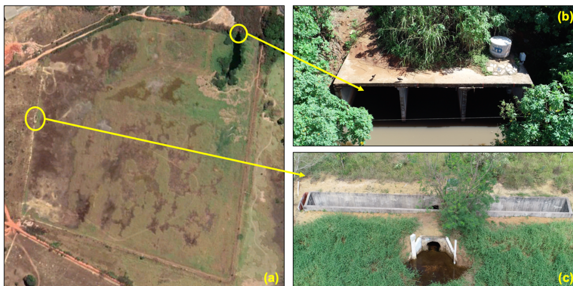
Figura 4.4 – (a) Bacia de detenção do Guará com foco na localização das estruturas de entrada e saída; (b) Galeria de entrada; (c) Vertedor e descarga de fundo na saída.
