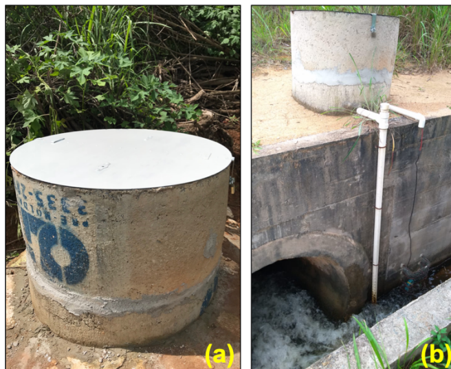
Figura 4.40 – Estrutura para alocar o amostrador automático: (a) Na entrada; (b) Na saída da lagoa de detenção do Guará.
