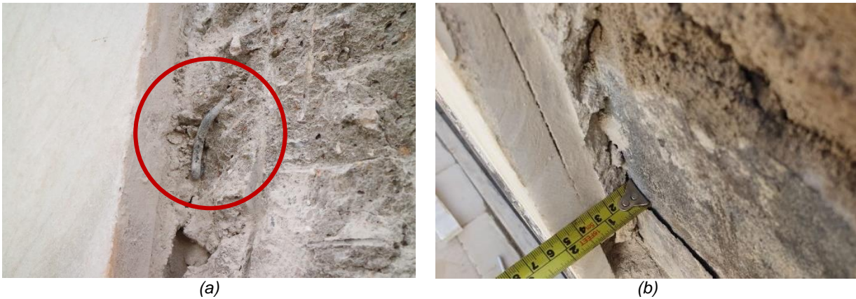
Figura 4.19: Prospecções 02 e 05: a) Arame de fixação de aço galvanizado 1/8, outubro de 2018; b) Camada de impermeabilização em trecho junto ao espelho d'água, abril de 2019. Fotos: Autora, 2018 e 2019.
