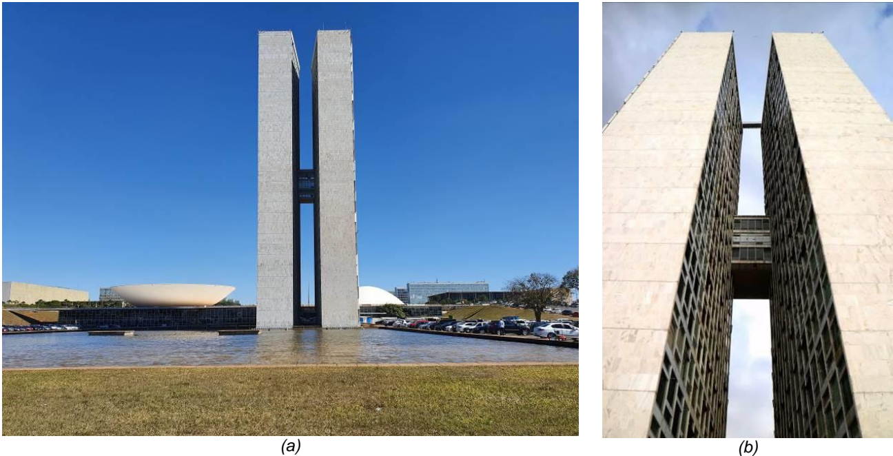
Figura 4.3: Torres do Congresso Nacional. a) vista a partir do espelho d'água, a Sudeste, b) vista das fachadas internas de esquadrias e das passarelas de ligação entre as torres. Foto: Autora, 2019.
