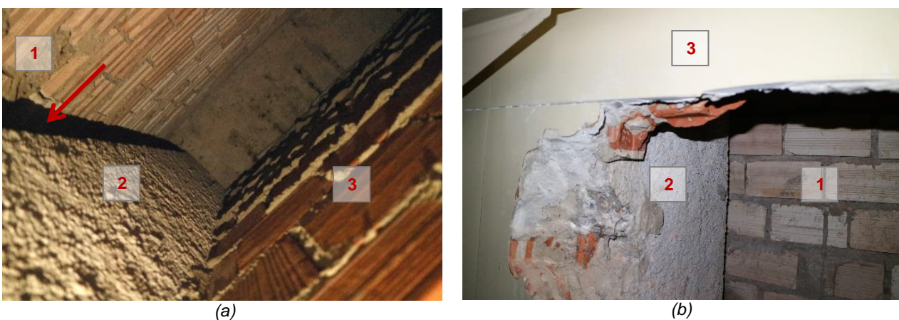
Legenda: 1. Parede externa; 2. Pilar; 3. Parede interna.
