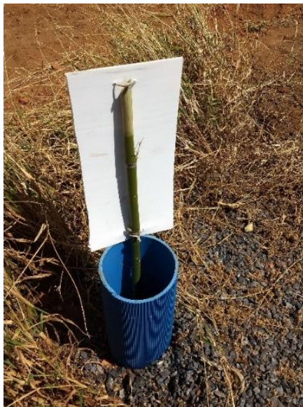
Figura 4.7. Poço tubular aberto sem isolamento sanitário (pré-filtro em contato direto com a superfície). Vetor para a rápida percolação de águas da chuva ou irrigação e de materiais lixiviados. Diâmetro do revestimento de 6 polegadas.
