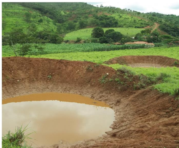
Figura 4.8. Exemplo de “sistema barraginha” após evento de chuva. Imagem retirada da Circular Técnica nº 177 da EMBRAPA.
