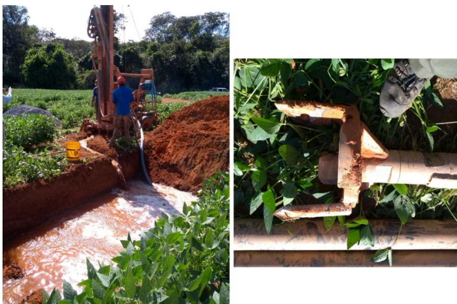
Figura 3.4. Torre de perfuração com a respectiva caixa de lama e broca utilizada para as perfurações.
