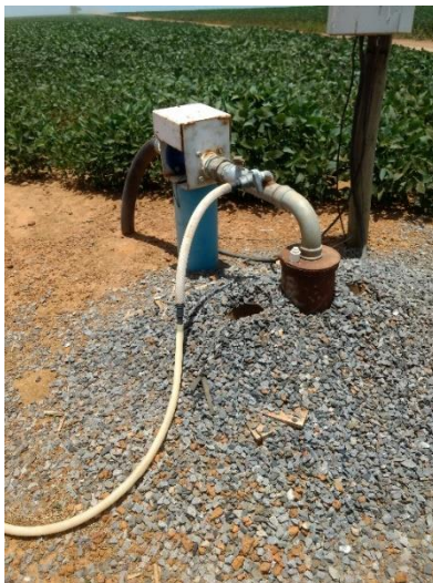
Figura 4.3. Situação comum a todos os poços existentes na região do Aquífero Batalha. A brita em torno do tubo de aço é diariamente colocada no espaço anelar do poço, por meio de um pequeno orifício na laje de concreto existente.
