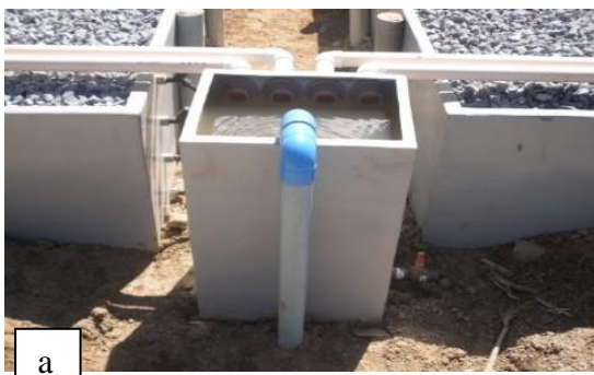
FIGURA 5. Caixa de passagem para os leitos cultivados (a), vertedouros triangulares no interior da caixa de passagem (b).
