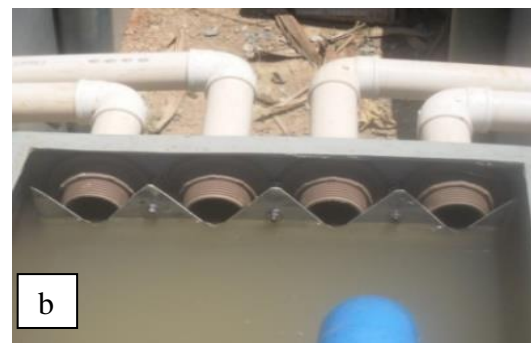
FIGURA 5. Caixa de passagem para os leitos cultivados (a), vertedouros triangulares no interior da caixa de passagem (b).
