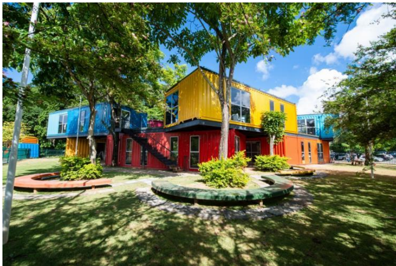
Figura 6- Centro de Inovação Colabore
