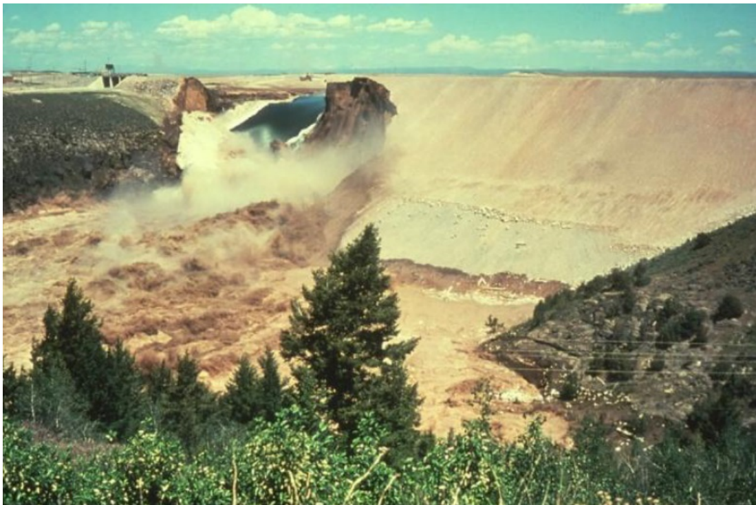
Figura 2.3: Ruptura da barragem de Teton. Fonte: Uemura, 2009 [47].
