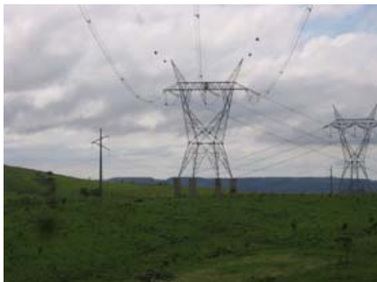
Torre RB30 apoiada em fundação "Sapata"
