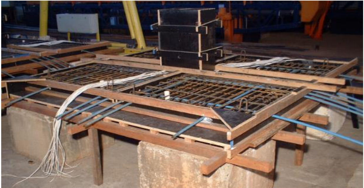
Figura 3.25 Fotografia das lajes prontas para serem concretadas
