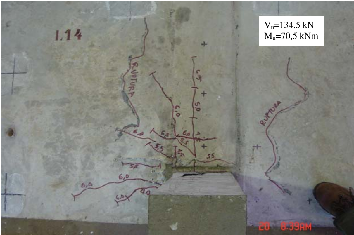
Figura 4.68 Ruptura da laje do modelo L14
