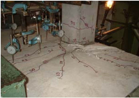
Primeiras fissuras L13
