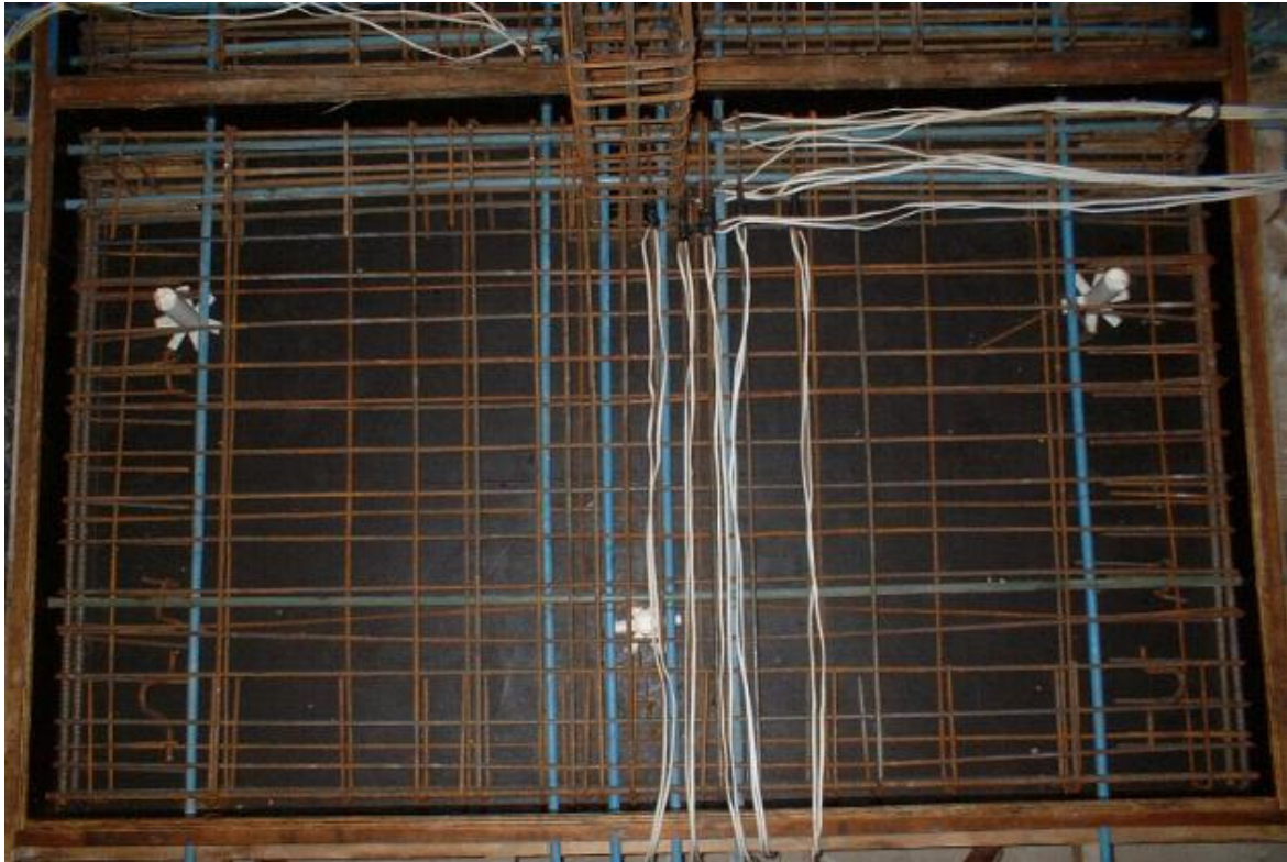
Figura 3.24 Fotografia da armadura da laje L15
