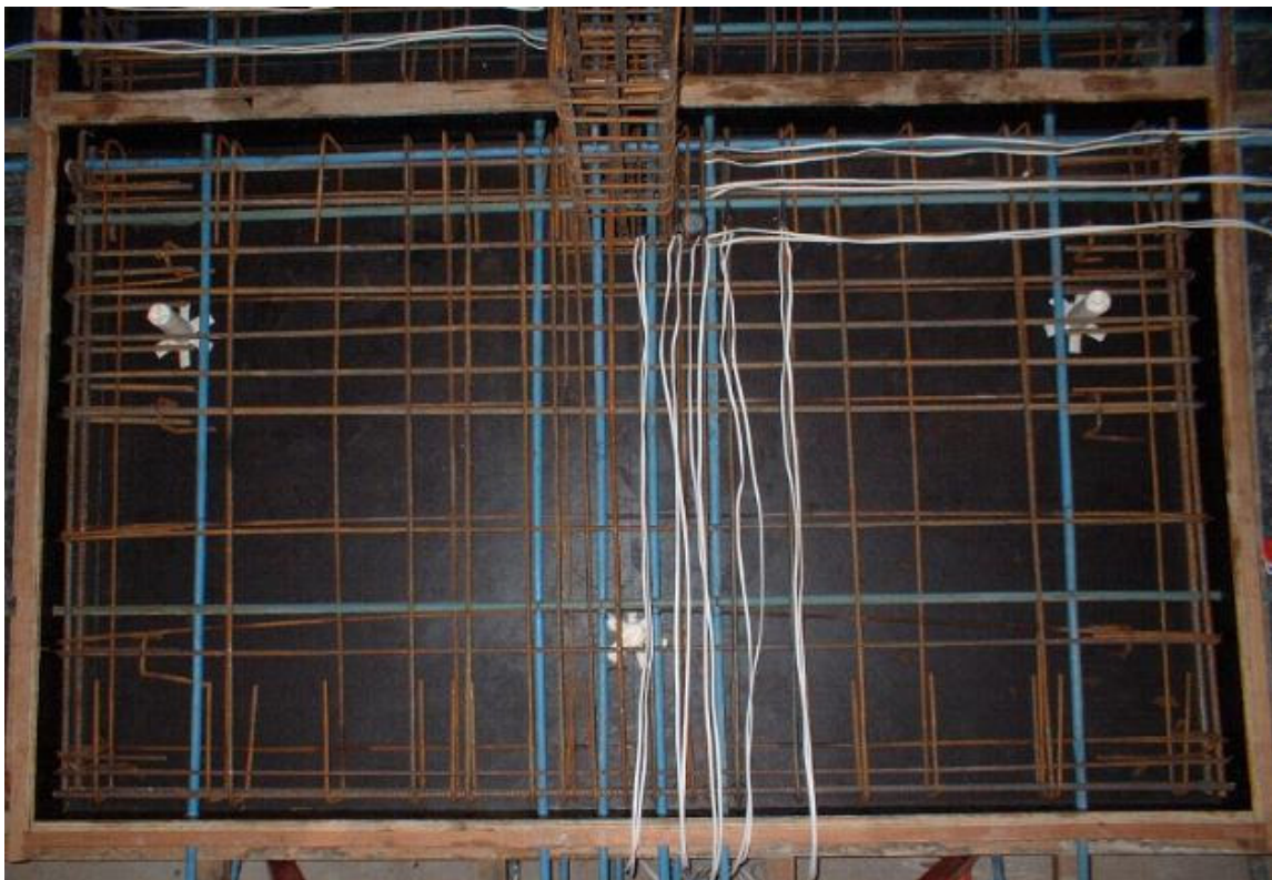
Figura 3.20 Fotografia da armadura da laje L11
