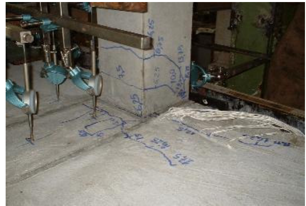
Primeiras fissuras: L6
