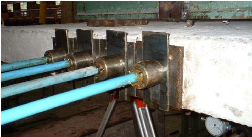
Figura 3.37 Detalhe após a protensão e reprotensão, com chapas de reprotensão posicionadas
