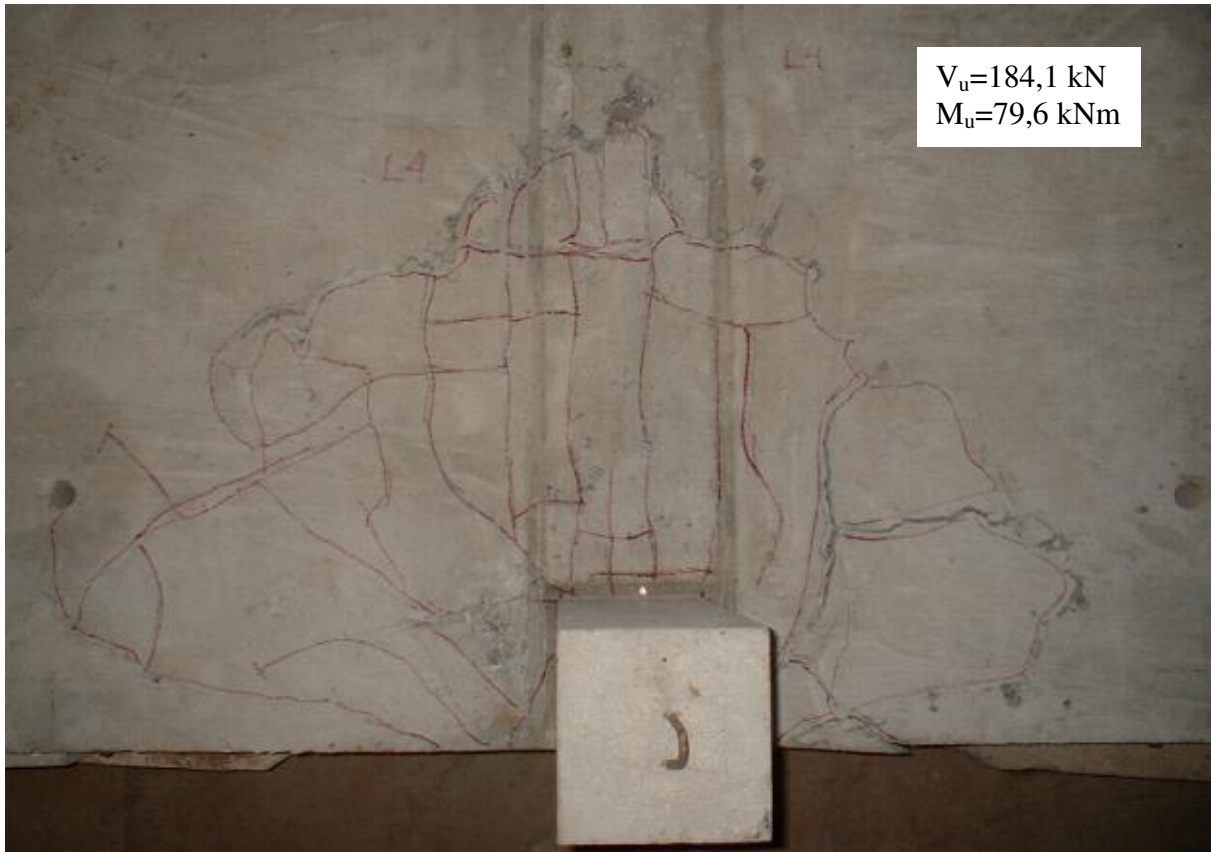
Figura 4.48 Ruptura da laje L4
