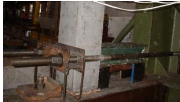
c) Fixação no pilar inferior
