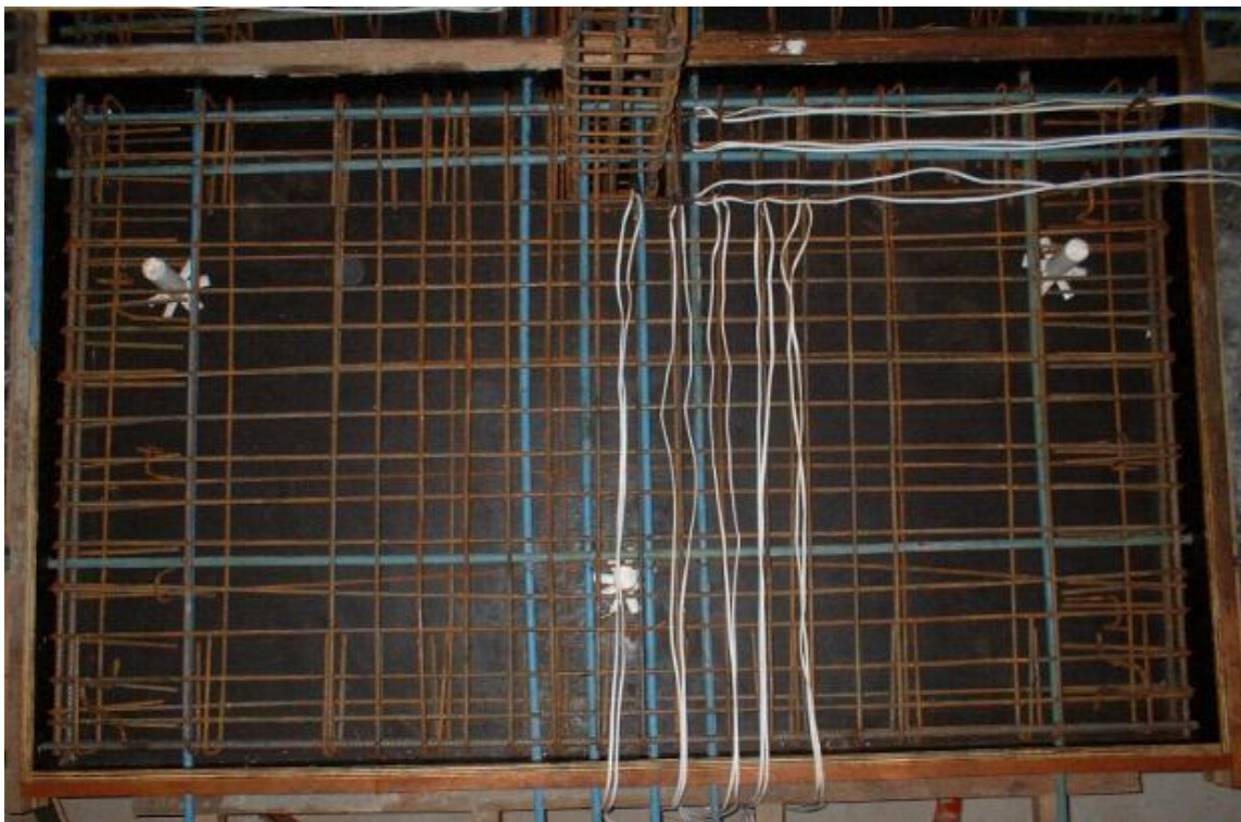
Figura 3.22 Fotografia da armadura da laje L13
