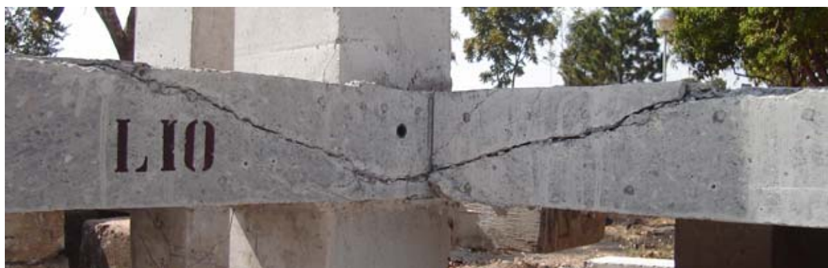
Figura 4.61 Seção transversal da ruptura laje L10
