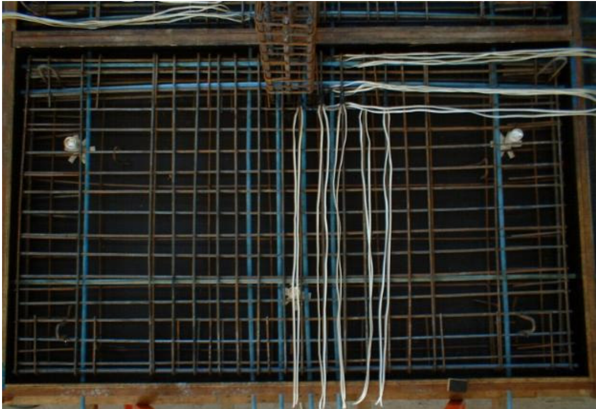
Figura 3.23 Fotografia da armadura da laje L14
