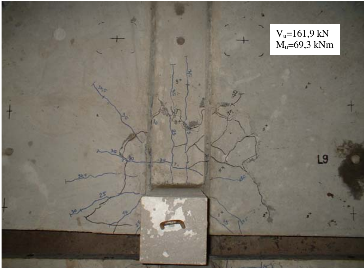
Figura 4.58 – Ruptura da laje do modelo L9.
