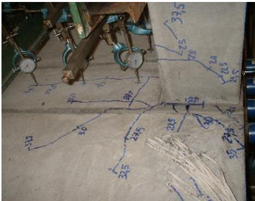
Primeiras fissuras: L5
