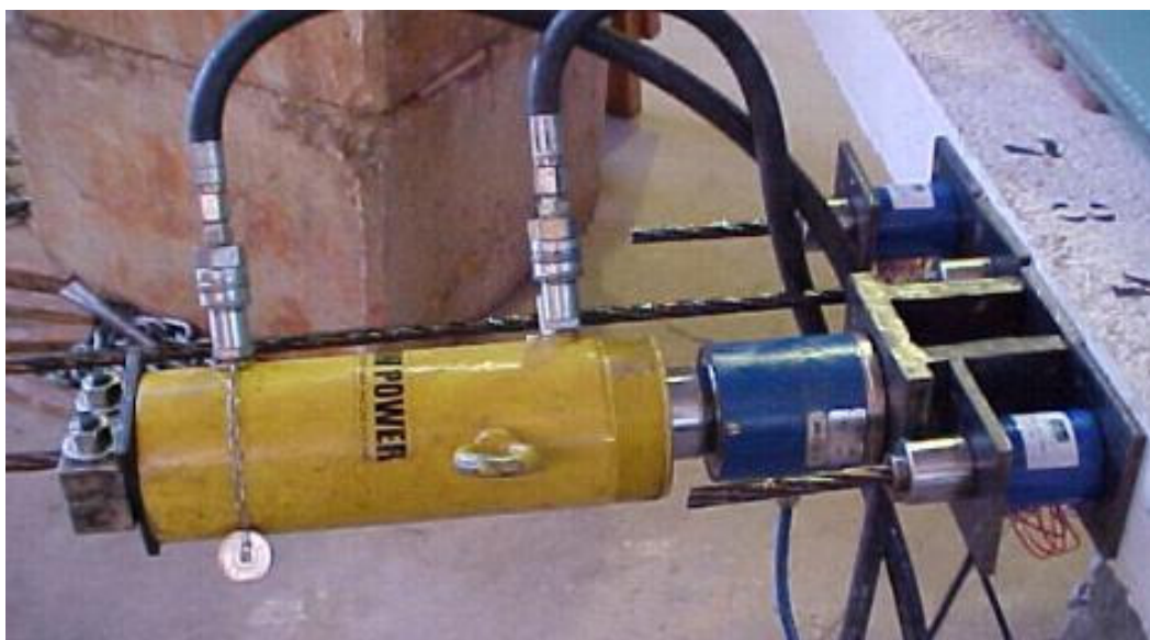
Figura 3.36 Sistema de protensão posicionado
