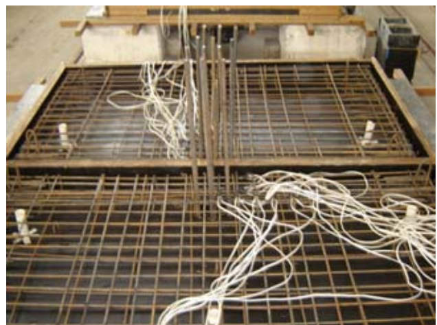
b) Posição dos canos de PVC (furos nas lajes)
