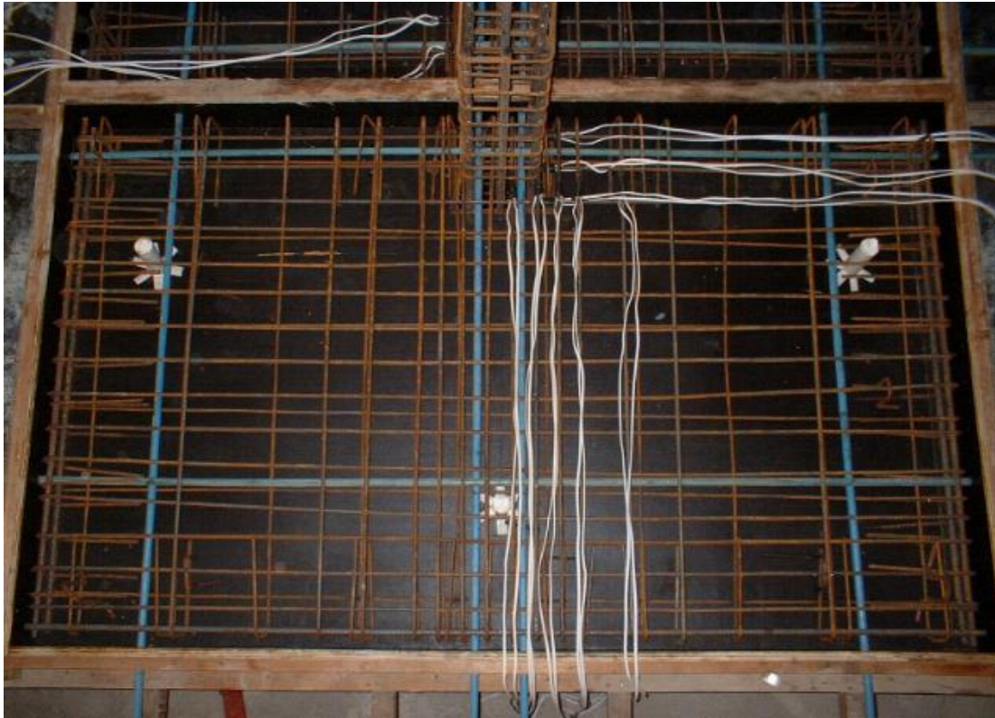
Figura 3.19 Fotografia representativa da armadura das lajes L8, L9 e L10
