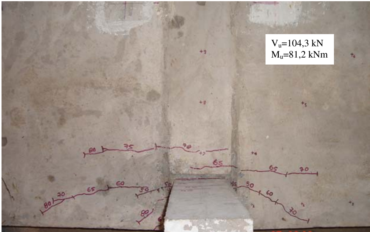
Figura 4.70 Ruptura da laje do modelo L15
