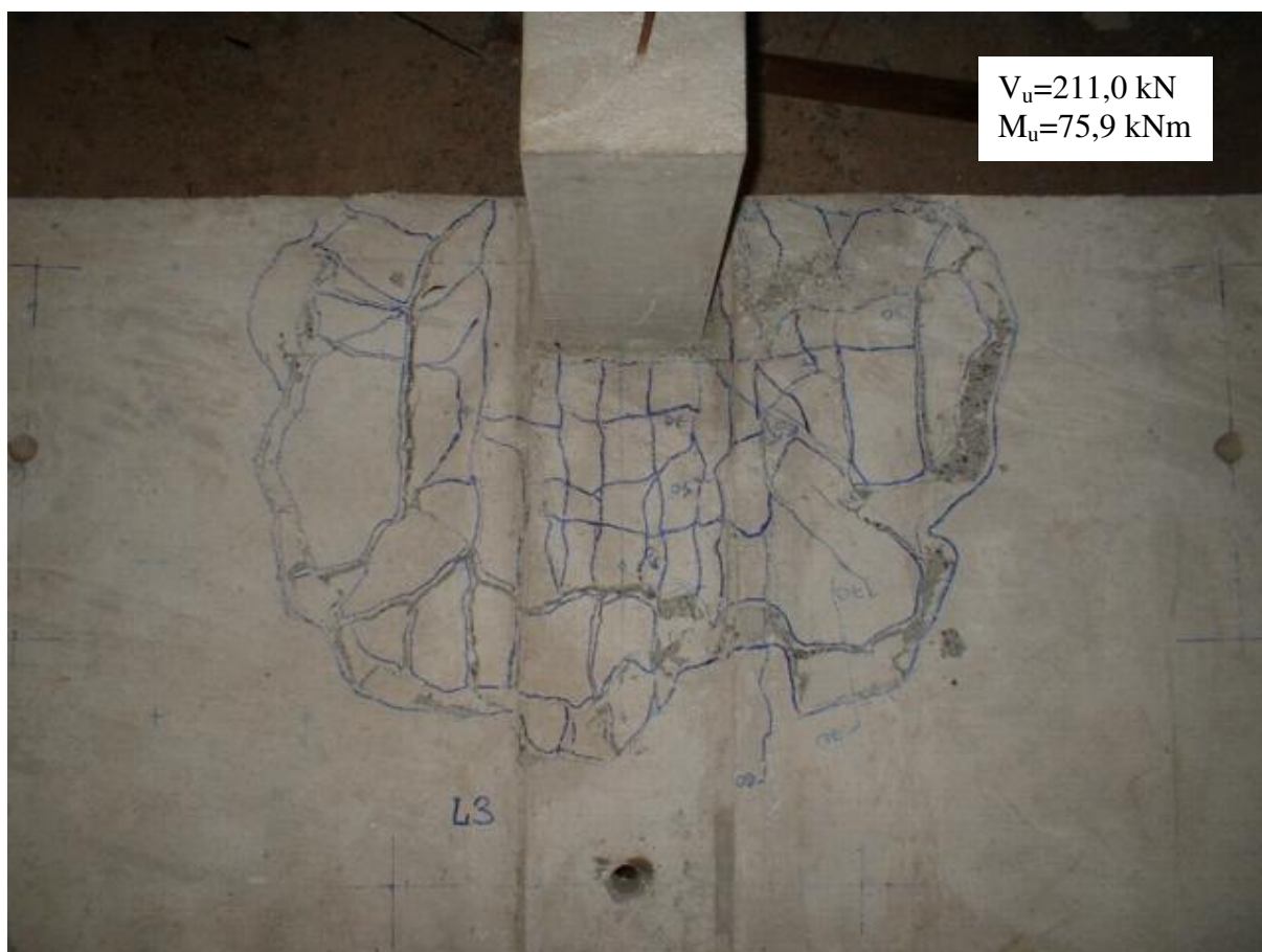
Figura 4.46 Ruptura da laje L3
