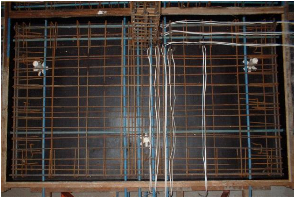
Figura 3.21 Fotografia da armadura da laje L12
