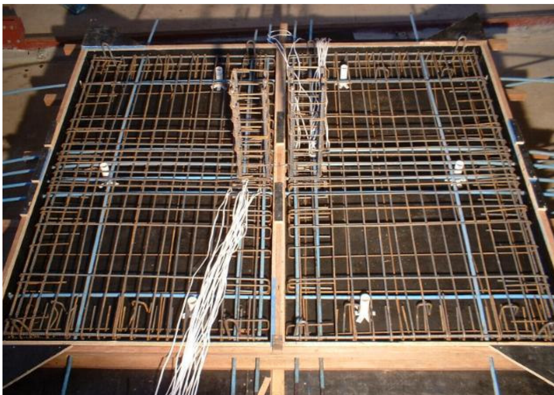
Figura 3.18 Fotografia da forma e armadura para as lajes L1 a L7
