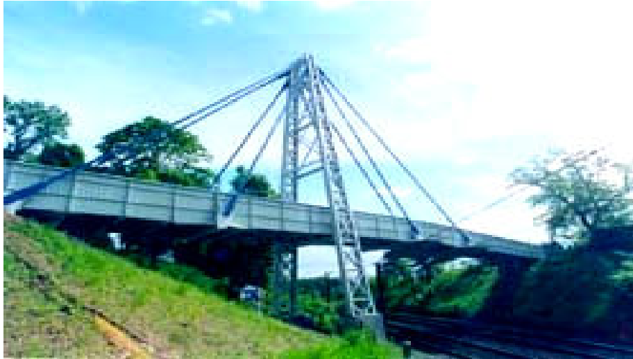
Figura 2.13 - Ponte de compósito (MENDONÇA, 2005).
