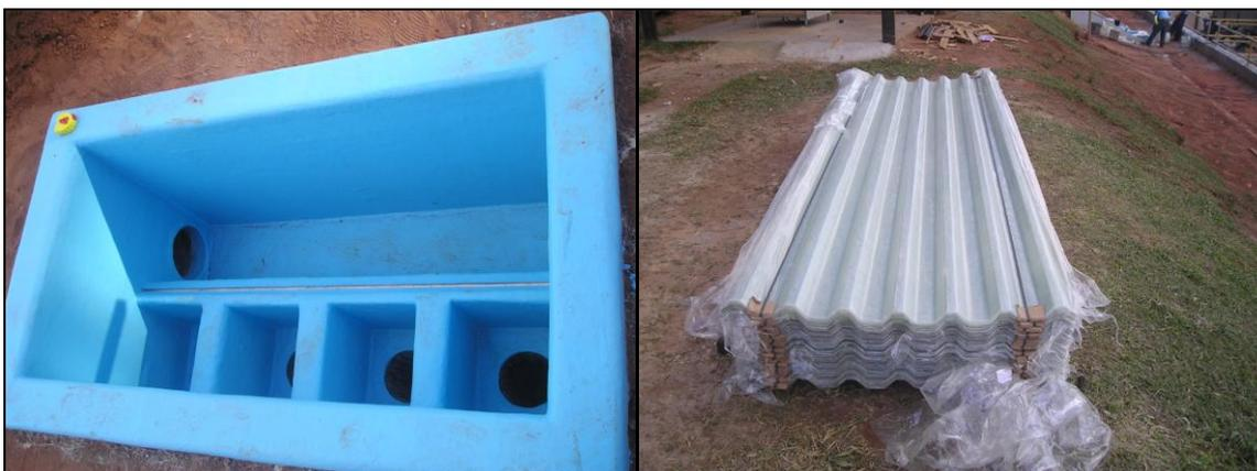
Figura 5.44 – Implantação de alterações de projeto nos reatores UASB da ETE Paranoá. Revestimento das caixas de coleta e separadores de fases em fibra de vidro.
