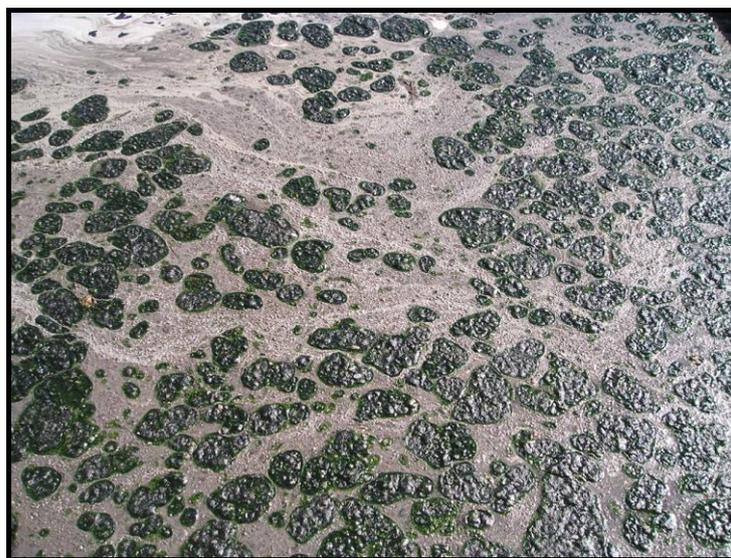
Figura 5.35 – Formação de espuma de coloração esverdeada no reator anaeróbio de fluxo ascendente da estação de tratamento de esgotos do Gama.
