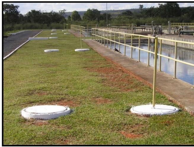
Figura 5.17 – Vista do sistema de descarga de lodo dos reatores anaeróbios da ETE Gama.
