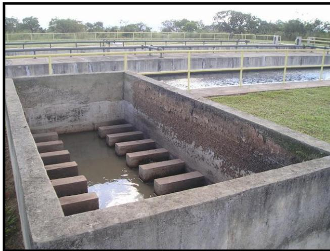
Figura 5.12 – Caixa de distribuição de vazão afluente aos reatores anaeróbios da ETE Gama.
