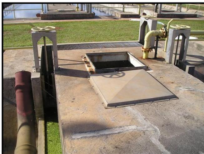
Figura 5.18 – Vista do sistema de remoção de espuma dos reatores anaeróbios ETE Gama.
