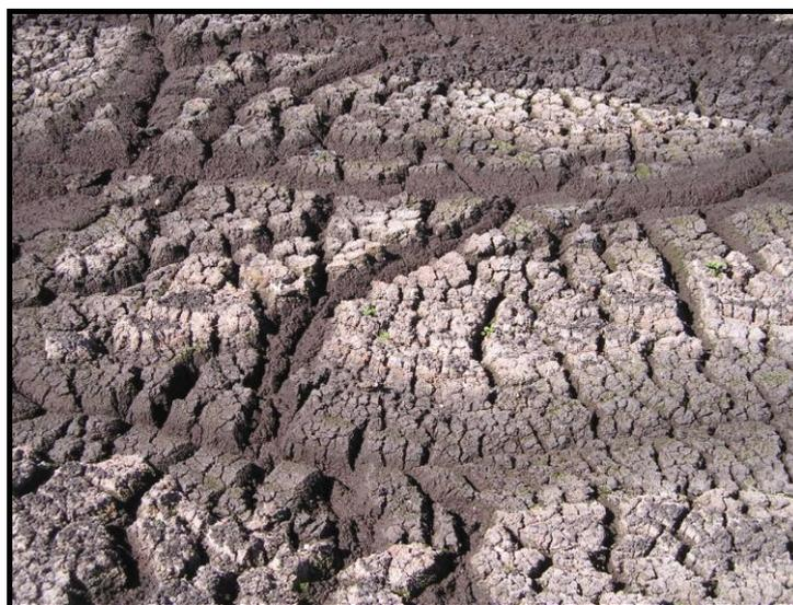
Figura 5.36 – Formação de espuma de coloração acinzentada no reator anaeróbio de fluxo ascendente da estação de tratamento de esgotos do Gama.
