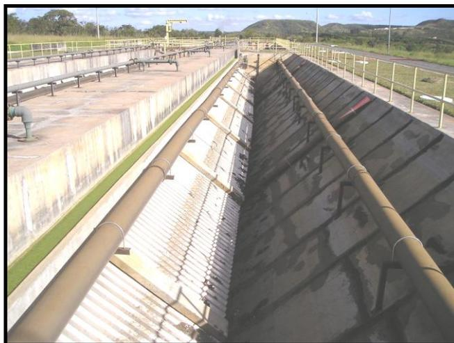
Figura 5.15 – Vista parcial das tubulações de distribuição e coleta dos esgotos e sistema de diluição e descarga de lodo dos reatores anaeróbios da ETE Gama.
