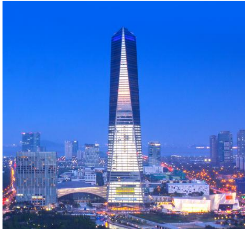
Figura 3.3 Edifício Northeast Asia Trade Tower, Coréia do Sul
