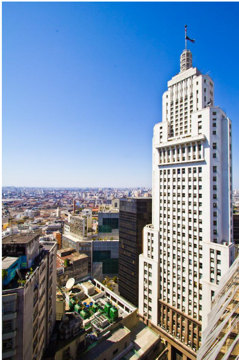
Figura 2.6 – Edifício Altino Arantes – São Paulo Foto: F. J. Jrabeck – Fonte: saopauloantiga.com.br
