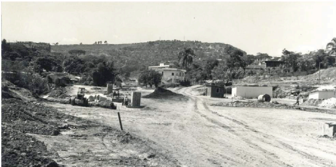
Foto 3 - Trecho em obras da Avenida Silva Lobo, aproximadamente ano de 1970. Fonte: SUDECAP
