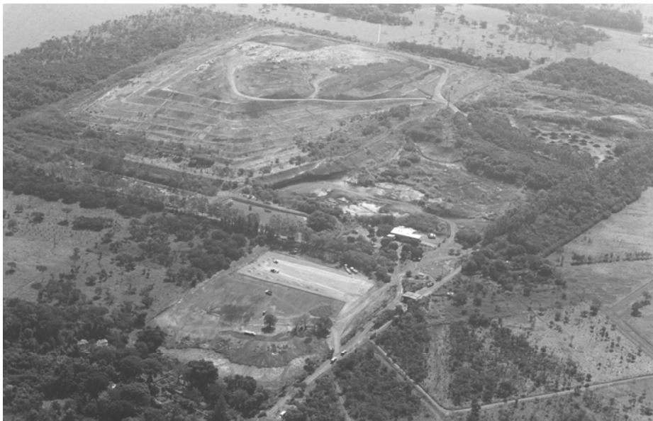
Figura 2.2 – Aterro Sanitário de Goiânia (GYN). Fonte: Google Earth (2007).
