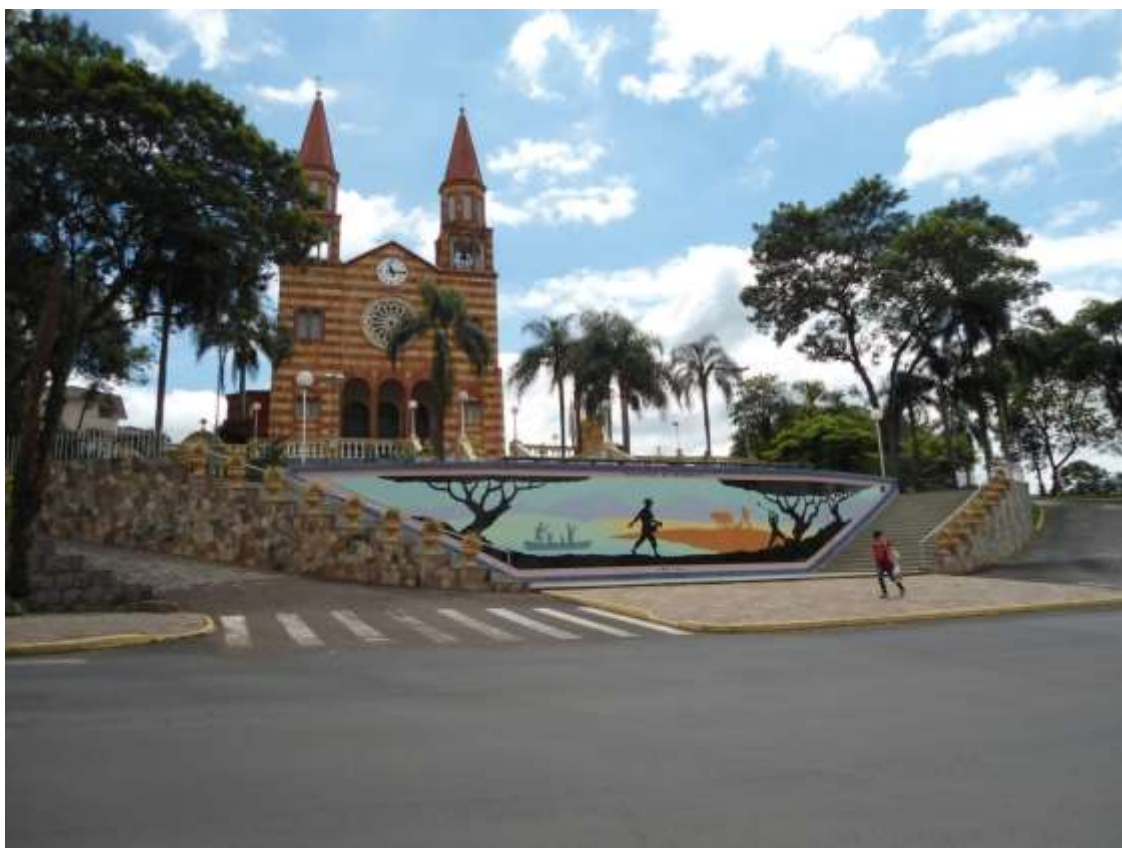
Imagem 10 - A Igreja Matriz São Pedro em conjunto com o Painel Encantado ao Imigrante, em primeiro plano, foram adotados como símbolos oficiais do município. O mosaico que estampa a entrada da igreja foi inaugurado em memória do início da colonização italiana no município de Encantado, que remonta ao ano de 1882. Tirada em: 12/08/2015.
