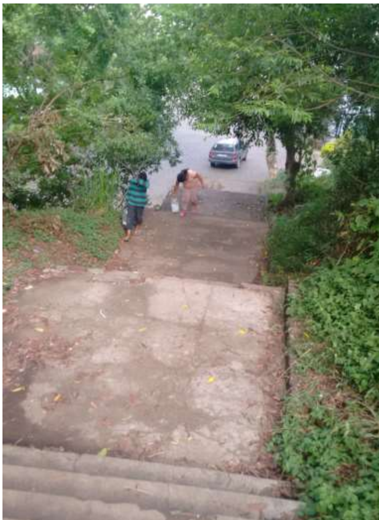
Imagem 7: Escadaria de acesso à rodovia RS 129. 28/12/2016.
