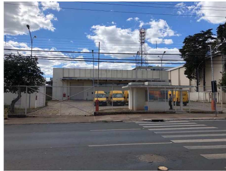
Figura 36 – Grupo 2 – Banco, Edifício de Escritórios e Galpão
